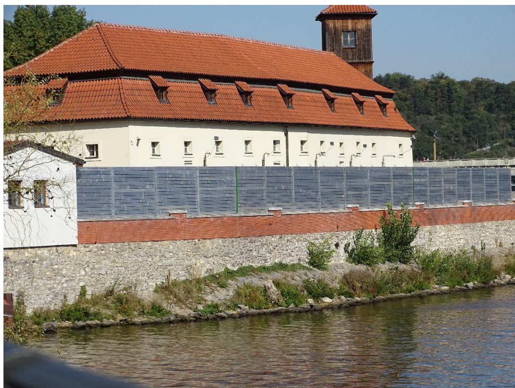
Dokončená instalace PPO úsek etapy 0002 z vnější strany hrazení (zdroj: vlastní)
