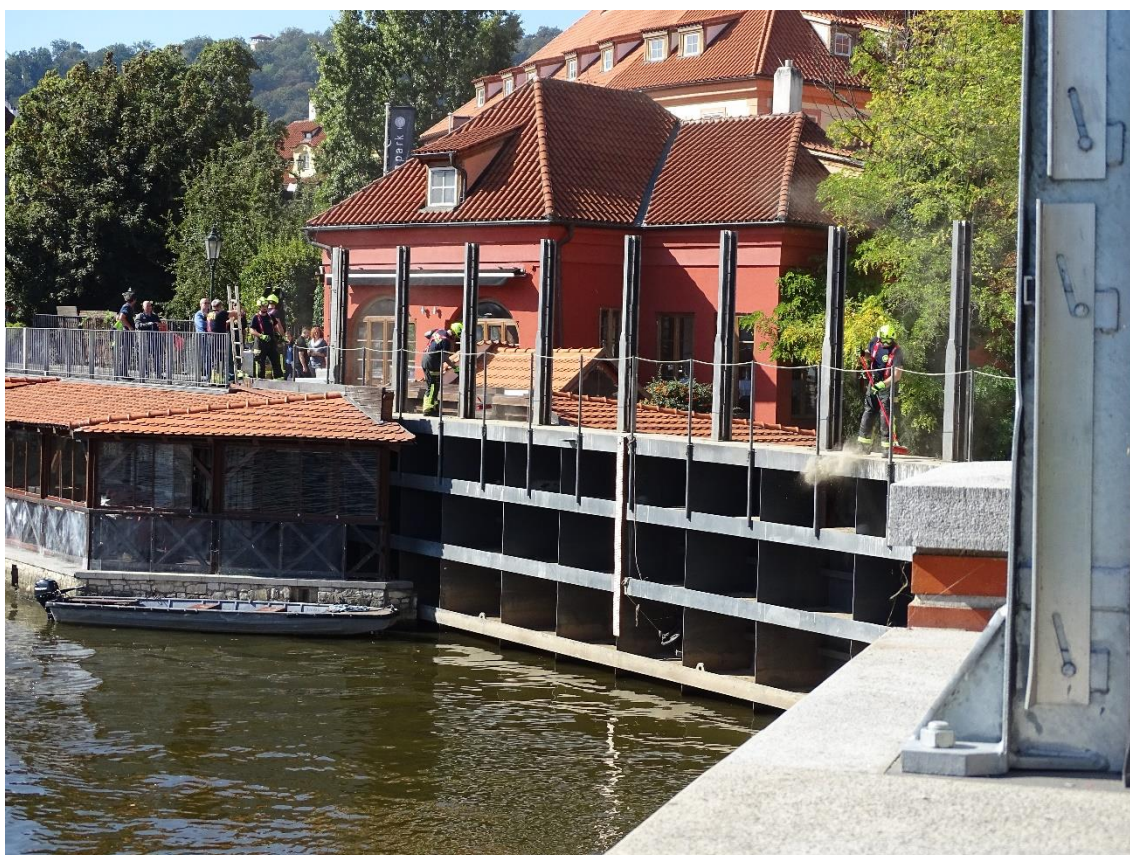
Instalace PPO úsek etapy 0002 – čištění kotevních desek a prahů pro správné usazení proního hrazení (zdroj: vlastní)
