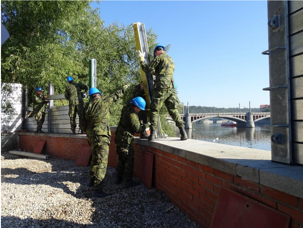
Průslušníci aktivních záloh AČR při stavbě PPO – instalace lomené (žluté) slupice (zdroj: vlastní)
