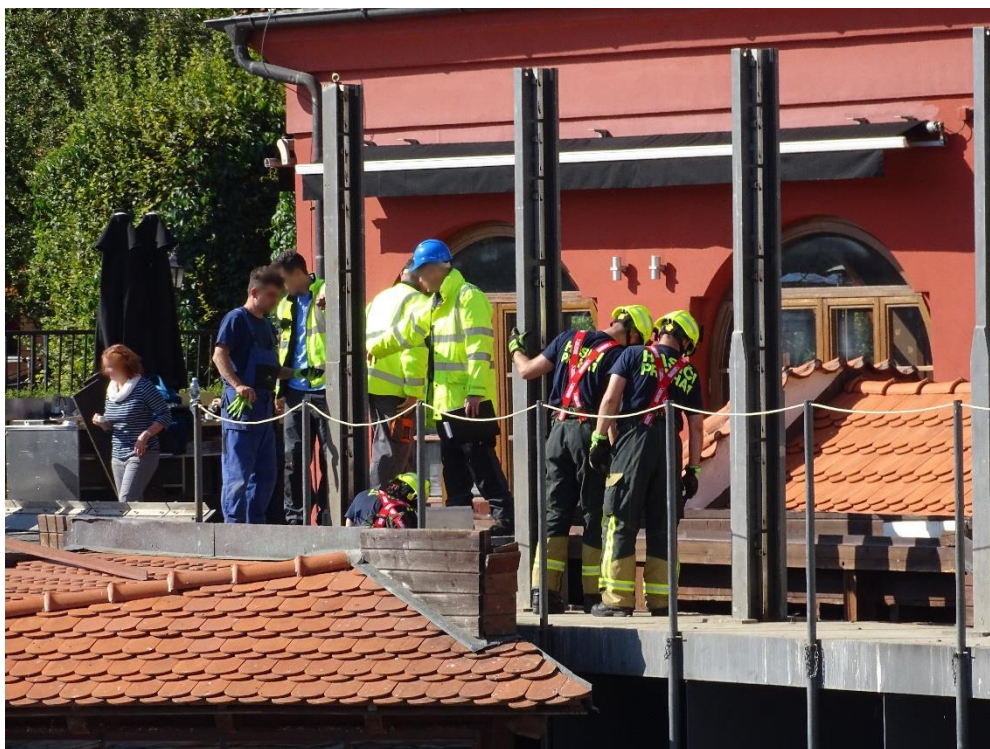
Příslušníci SDH Praha 1 a SSHMP při instalaci PPO – zasazování slupic do kotevní desky (zdroj: vlastní)
