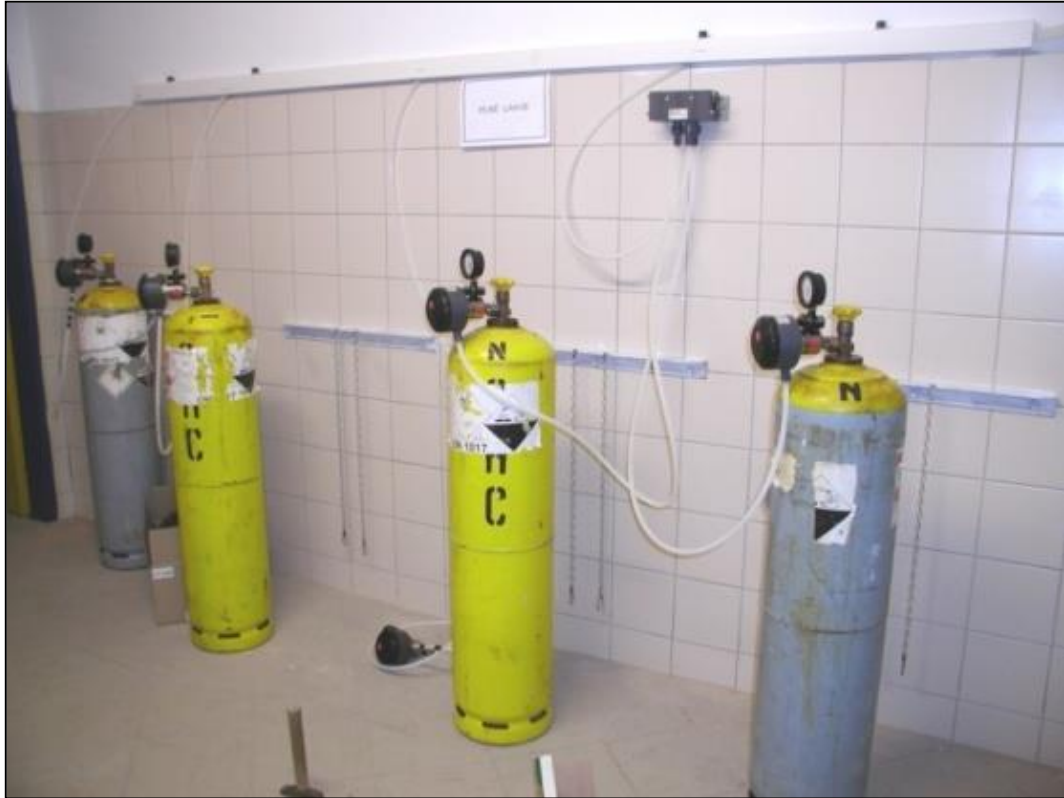
Obrázek 2 Úpravna pitné vody. Zdroj: HZS MSK
