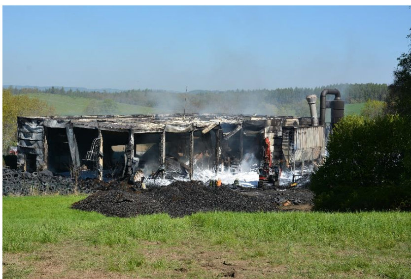
Obrázek 28 – Pohled v době lokalizace požáru [zdroj HZS SCK]
