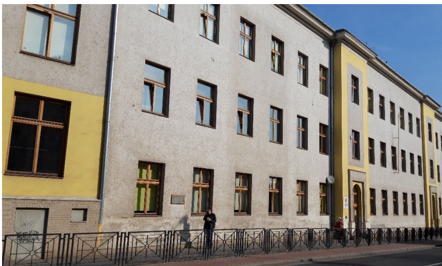
Obr. 7 – Hlavní vstup od komunikace [vlastní]
