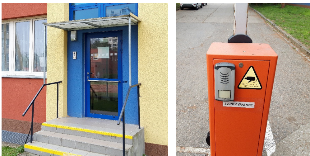
Obr. 18 – Boční vstup s kódovaným zámekem, vjezdová závora [vlastní]
