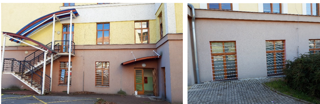
Obr. 14 - Otevřený technický vstup, mříže v přízemí [vlastní]
