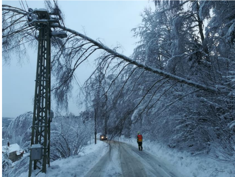
Obrázek 13 Pád stromu pod tíhou sněhu na nadzemní vedení distribuční sítě.
