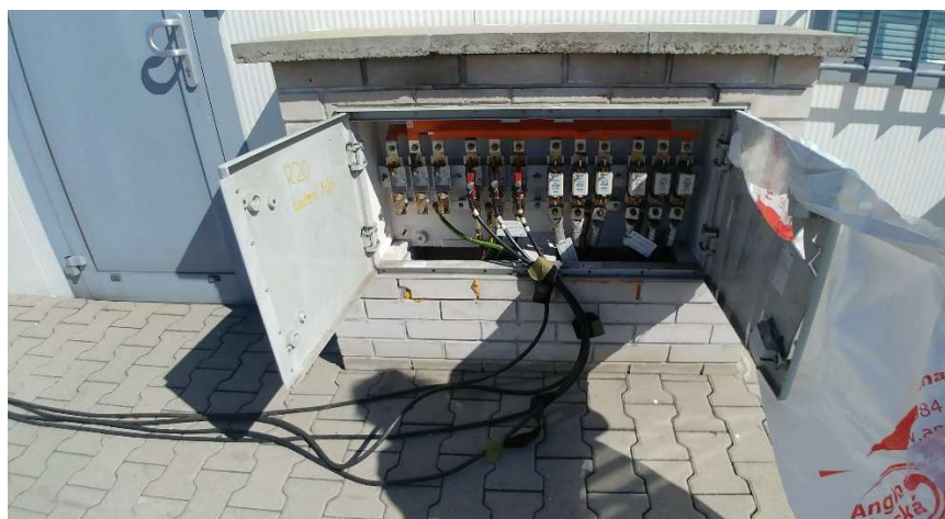
Obrázek 25 - Rozvaděč připojený ČS – foto vlastní
