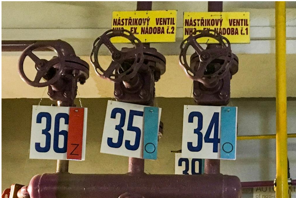
Obrázek 13 Nástřikové ventily pro obě ledové plochy [vlastní zdroj]
