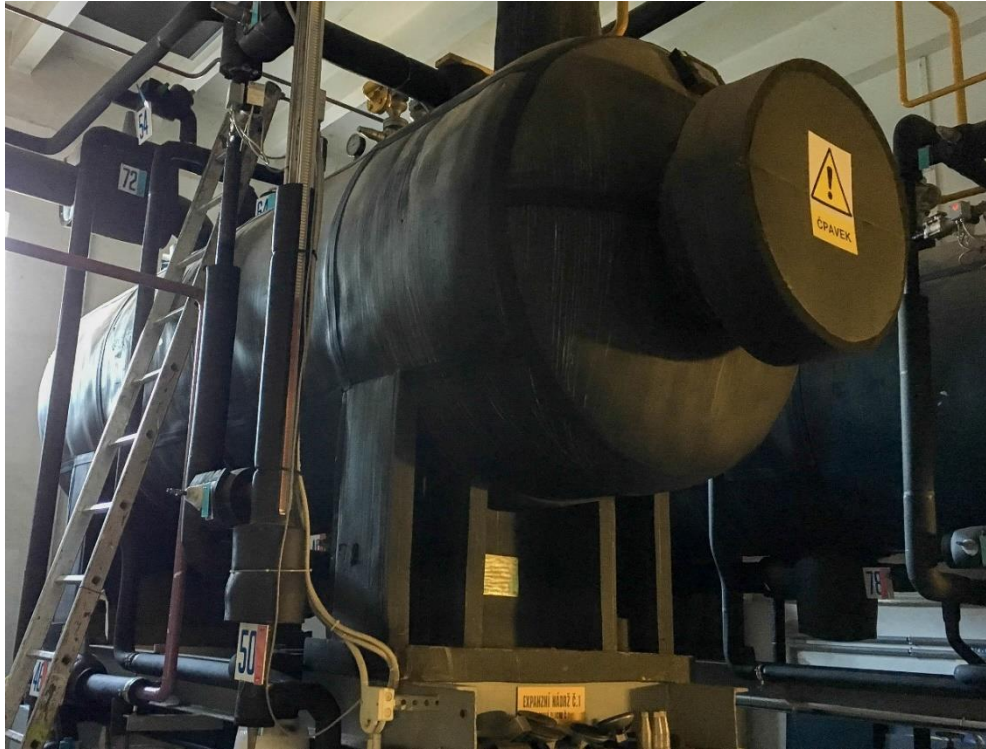
Obrázek 10 Expanzní nádrž NH 3 [vlastní zdroj]
