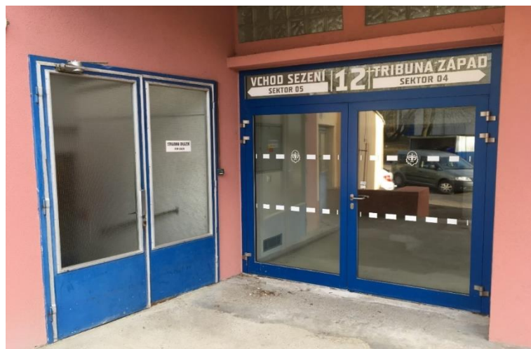
Obrázek 9 Zadní vchod do zimního stadionu v Kladně [vlastní zdroj]
