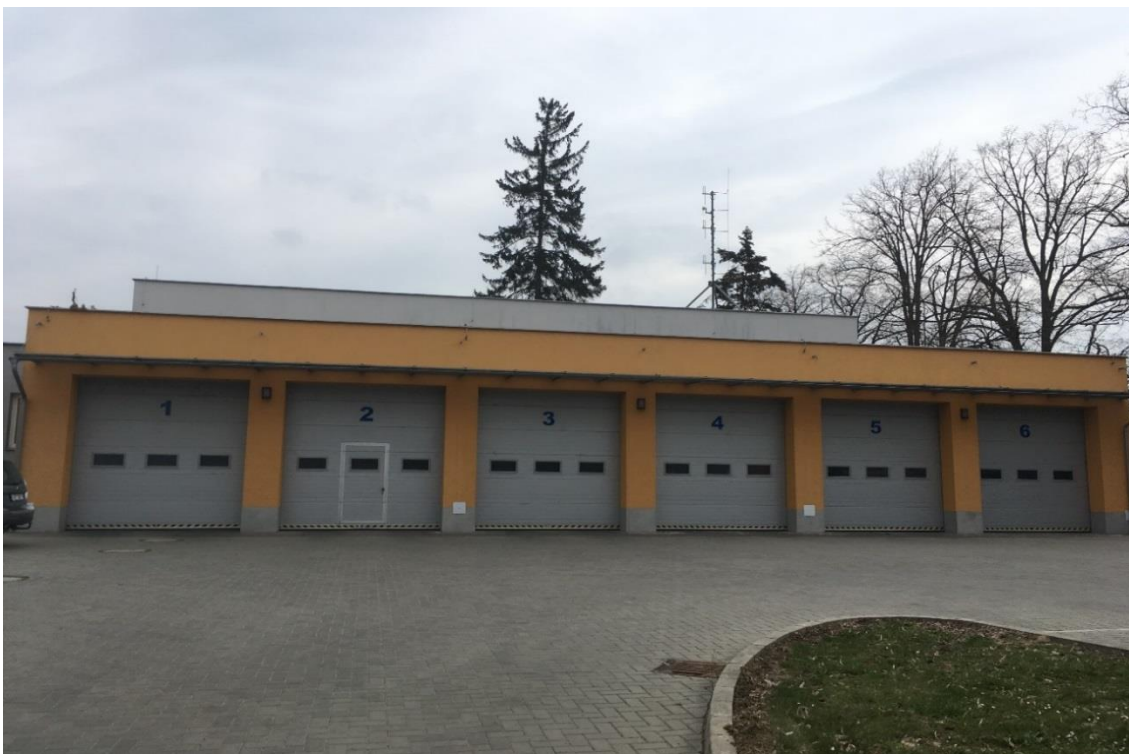
Obr. 3 - Garáže výjezdové základny ZZS ZK v Uherském Hradišti [zdroj: vlastní]
