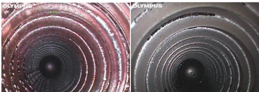
Obr. 22 Vlevo je endoskopický snímek zaneseného chladiče mědi před chemickým čištěním a vpravo je endoskopický snímek po chemickém čištění [10A, 11A].
