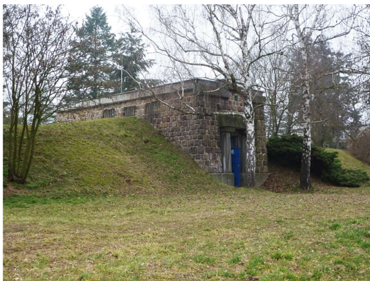
Obrázek 10 Zemní vodojem
