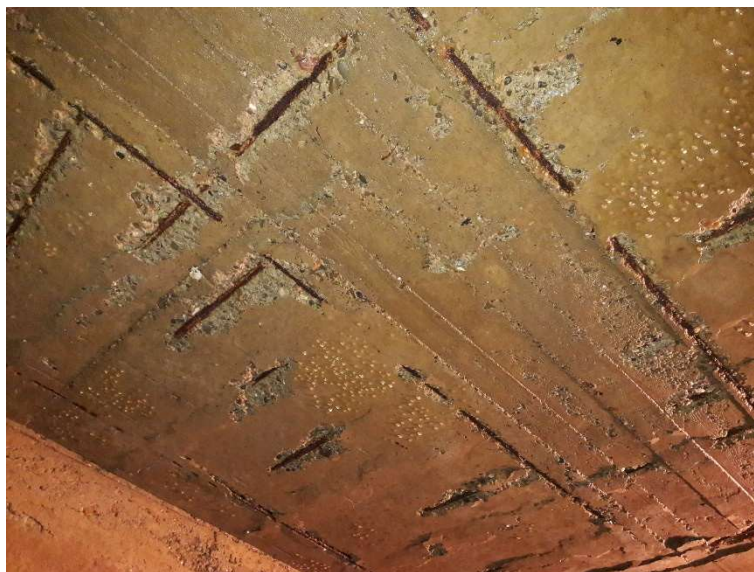
Obrázek 2 Koroze výztuže
