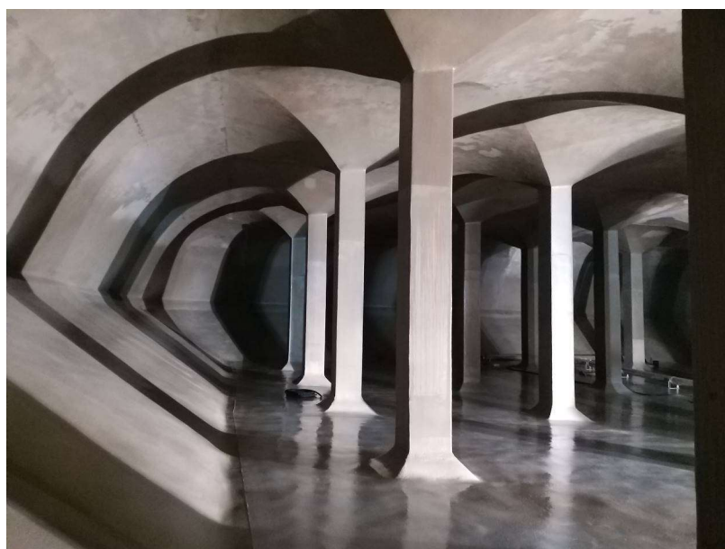
Obrázek 8 Ukázka posuzovaných vodojemů (VDJ Bílá Hora 5000 m 3 po provedené sanaci)
