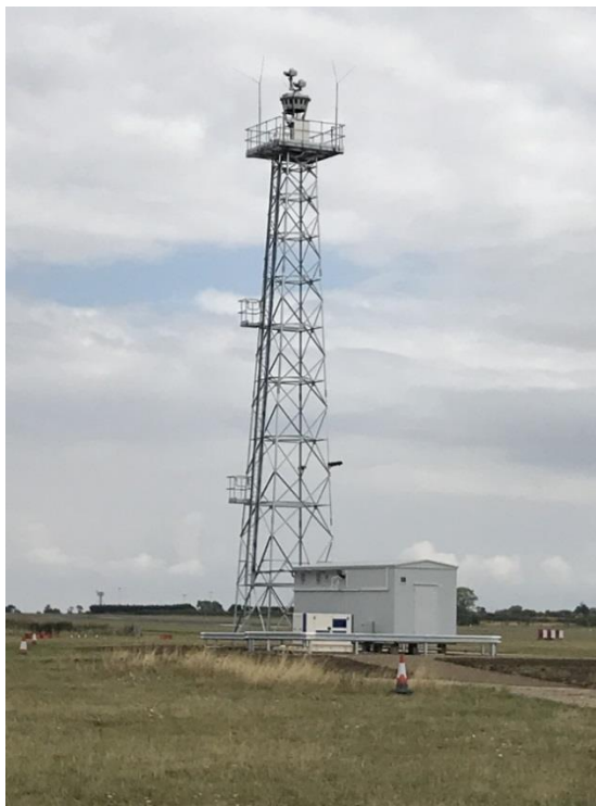
Obrázek č. 16 – příklad provedení konstrukce s kamerovým hnízdem s technickým zázemím na letišti Cranfield. Zdroj:[22]
