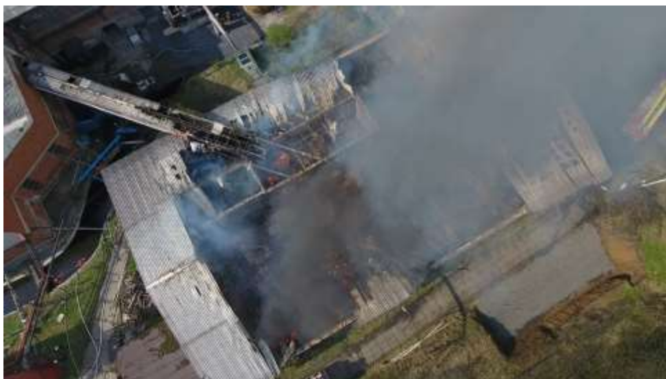
Obrázek 10 – Pohled z dronu DJI P4 při požáru haly v Ostrově (foto HZS KVK)
