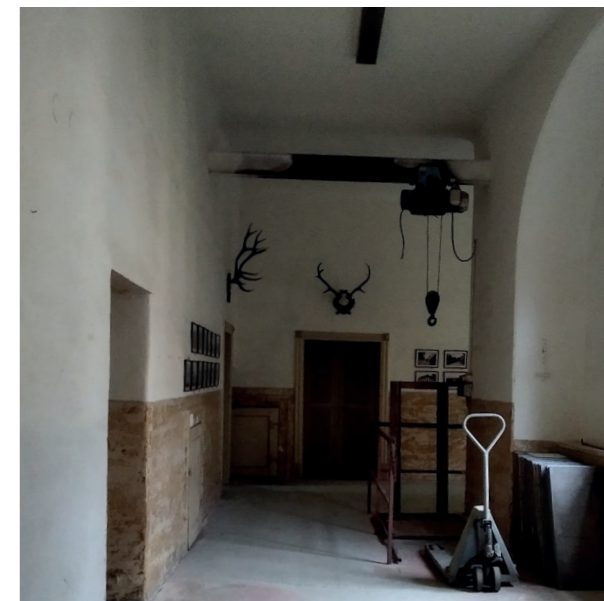
Výtah nevhodně narušuje celistvost arkádové chodby
