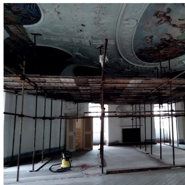
Štuk opadáva z dřevomorkou napadené dřevěné klenby
