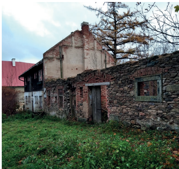
Zřícenina budovy hospodářského dvora a stavba z 20. století
