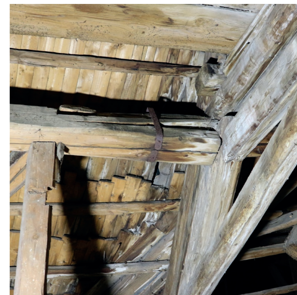
Tesařské prvky napadené dřevomorkou při úžlabí střechy
