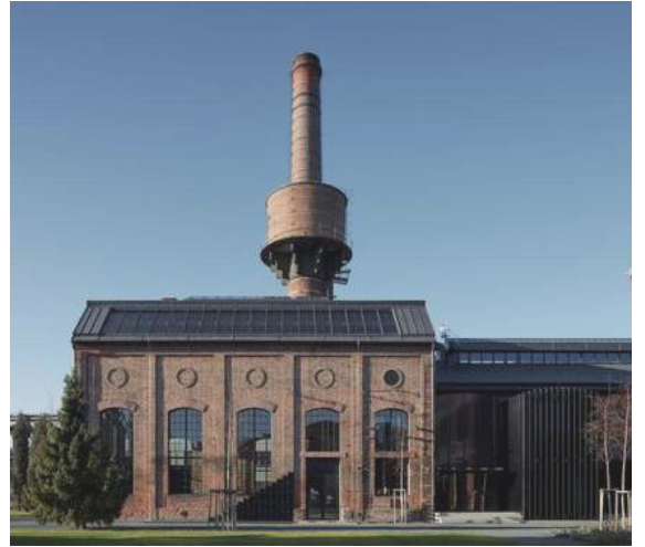
KOTELNA V LIBČICÍCH NAD VLTAVOU
