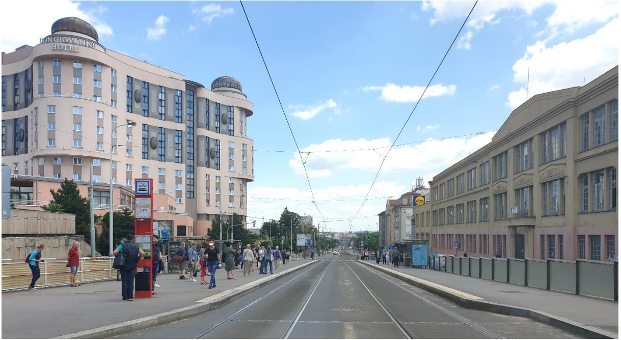
Obrázek 12: Pohled na tramvajové zastávky – A (vlevo) a B (vpravo)
