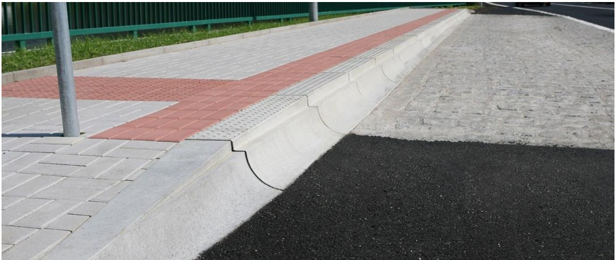
Obrázek 35: Ukázka zastávky s kasselským obrubníkem [16]
