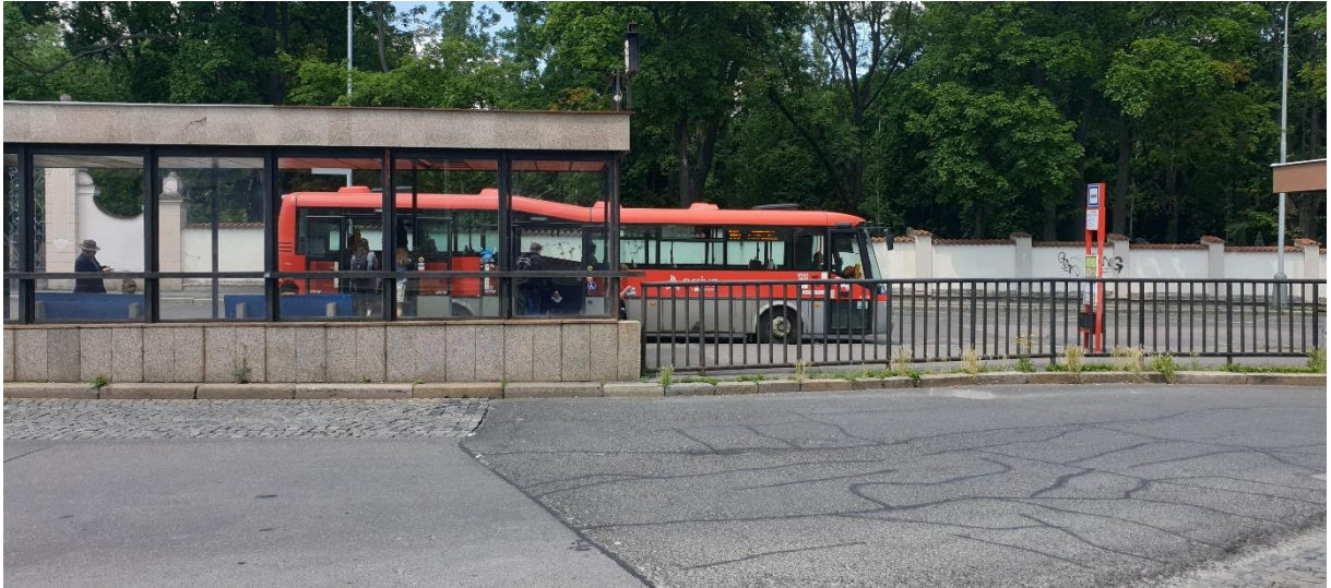
Obrázek 26: Pokračování zábradlí ke stanovištím mezinárodních autobusových linek.
