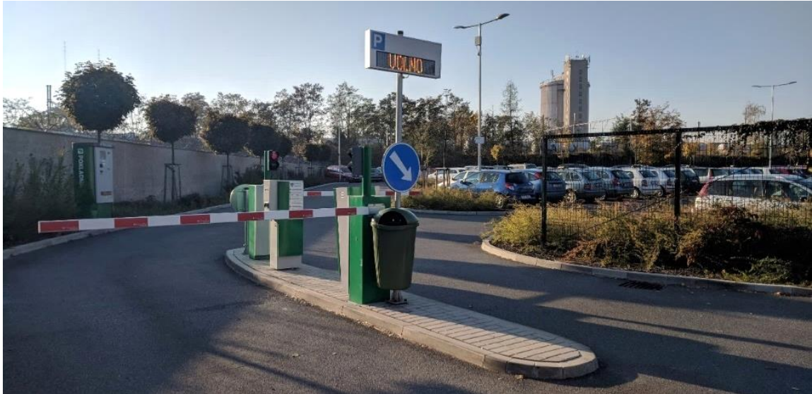
Obrázek 8 Vjezd na parkoviště P+R v ulici Klučovská v Českém Brodě
