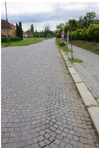
Obr. 41: Úsek č. 32 - chybějící VDZ 61
