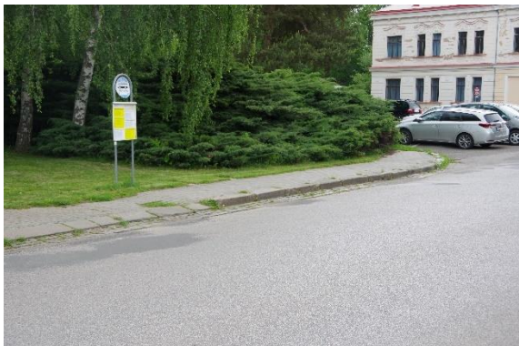
Obr. 46: Úsek č. 44 - Chybějící VDZ 66
