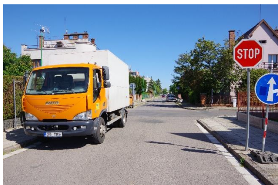
Obr. 8: Úsek č. 4 - Parkování v křižovatce a chybějící vodorovné značení 29
