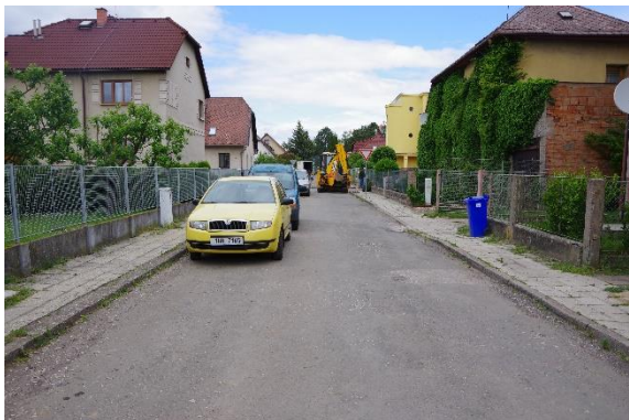
Obr. 35: Úsek č. 12 - Nedostatečný průjezdný profil 55
