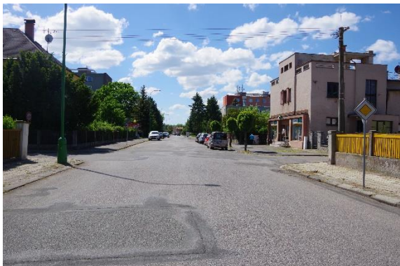
Obr. 20: Úsek č. 23 - Příliš rozlehlá křižovatka 41
