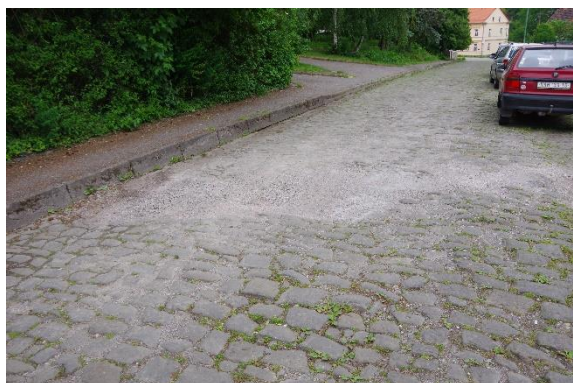
Obr. 47: Úsek č. 48 - Nedodržený průjezdný profil, Nevhodný povrch komunikace 67
