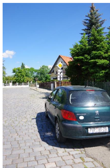
Obr. 19: Úsek č. 22 - Příliš rozlehlá křižovatka, nevhodně umístěné SDZ 40
