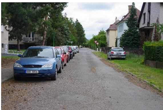
Obr. 37: Úsek č. 19 - Nedostatečný průjezdný profil 57
