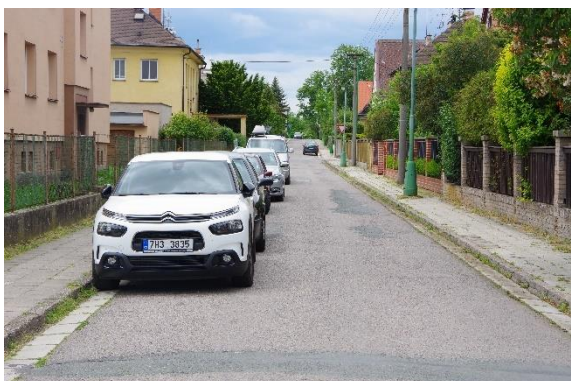
Obr. 59: Úsek č. 62 - Nedostatečný průjezdný profil 79
