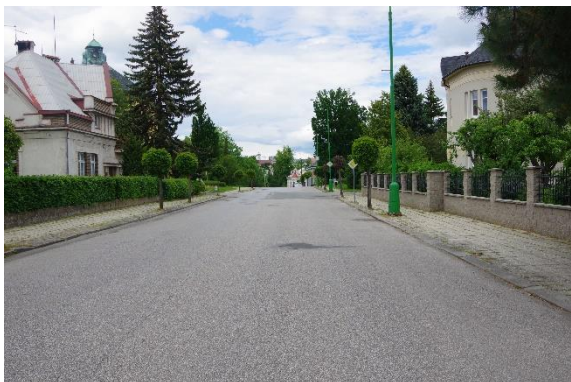
Obr. 49: Úsek č. 51 - Předimenzovaná šířka komunikace 69
