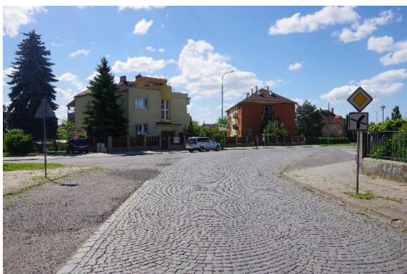
Obr. 18: Úsek č. 21 - Parkování v křižovatce, příliš rozlehlá křižovatka, umístění zastávky 39
