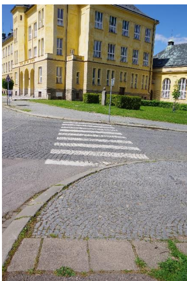
Obr. 21: Úsek č. 27 - Chybějící prvky pro OsSSPaO 43
