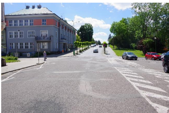
Obr. 30: Úsek č. 34 - Chybějící VDZ, chybějící prvky pro OsSSPaO, příliš rozlehlá křižovatka, parkování v křižovatce 50
