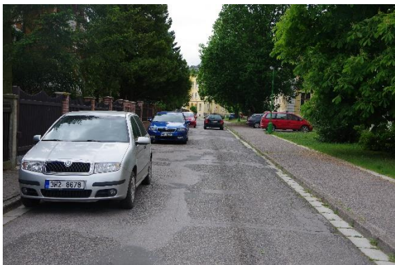
Obr. 48: Úsek č. 49 - Nedodržený průjezdný profil 68
