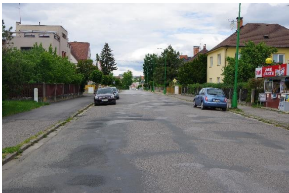
Obr. 51: Úsek č. 54 - Předimenzovaná šířka komunikace 71
