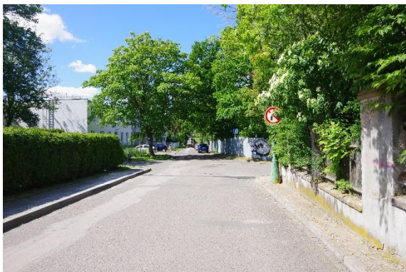
Obr. 22: Úsek č. 28 - Nevhodně umístěné SDZ 44
