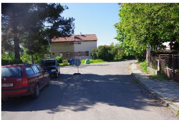
Obr. 12: Úsek č. 10 - Příliš rozlehlá křižovatka, umístění kontejnerů, nevhodné umístění SDZ, příliš vzrostlá zeleň 33
