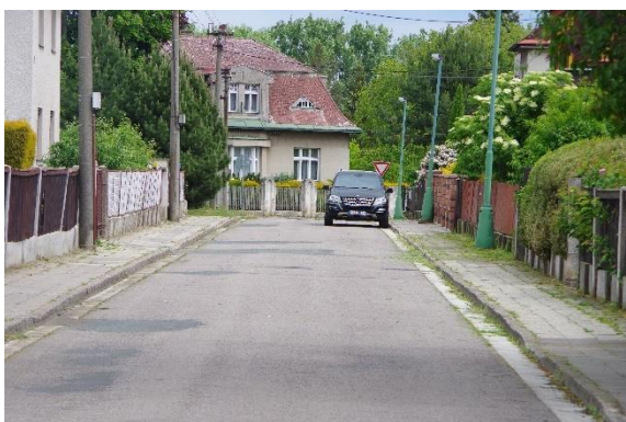
Obr. 54: Úsek č. 57 - Nedostatečný průjezdný profil 74
