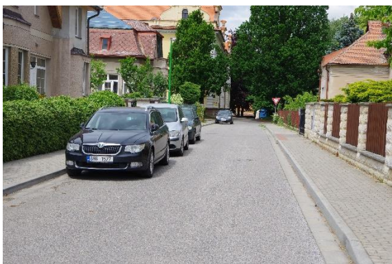
Obr. 53: Úsek č. 56 - Nedostatečný průjezdný profil 73
