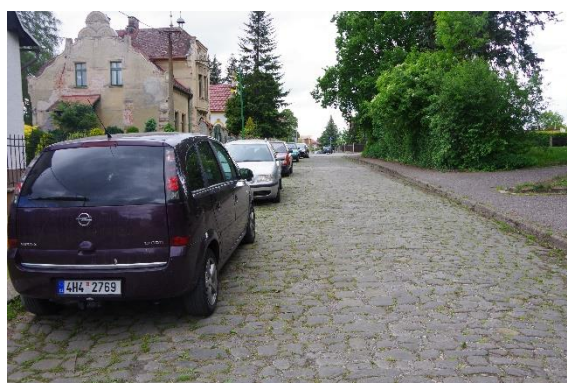
Obr. 47: Úsek č. 48 - Nedodržený průjezdný profil, Nevhodný povrch komunikace 67
