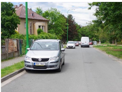
Obr. 40: Úsek č. 24 - Nedostatečný průjezdný profil 60
