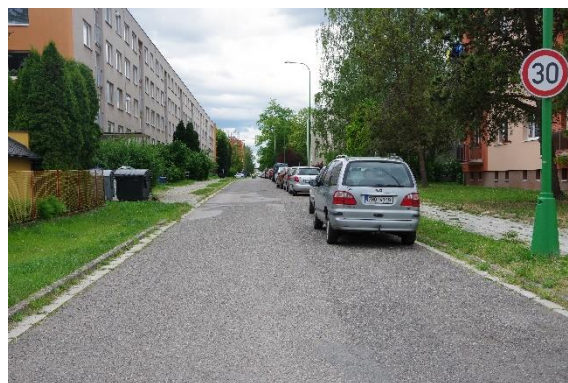
Obr. 55: Úsek č. 58 - Nedostatečný průjezdný profil, nevhodné umístění kontejneru 75
