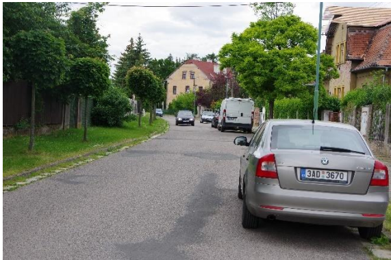
Obr. 57: Úsek č. 60 - Nedostatečný průjezdný profil 77
