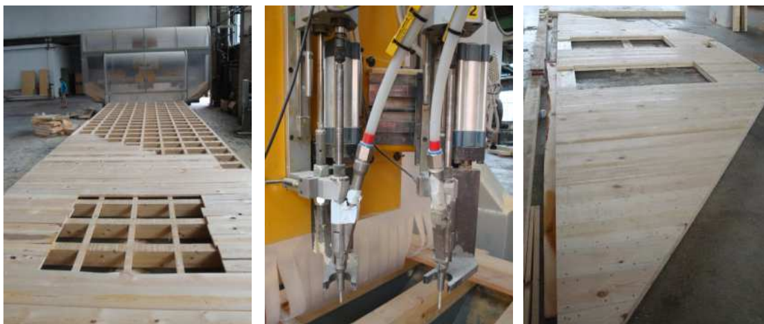
Obr. 2: Sestavování mechanicky spojovaných panelů
