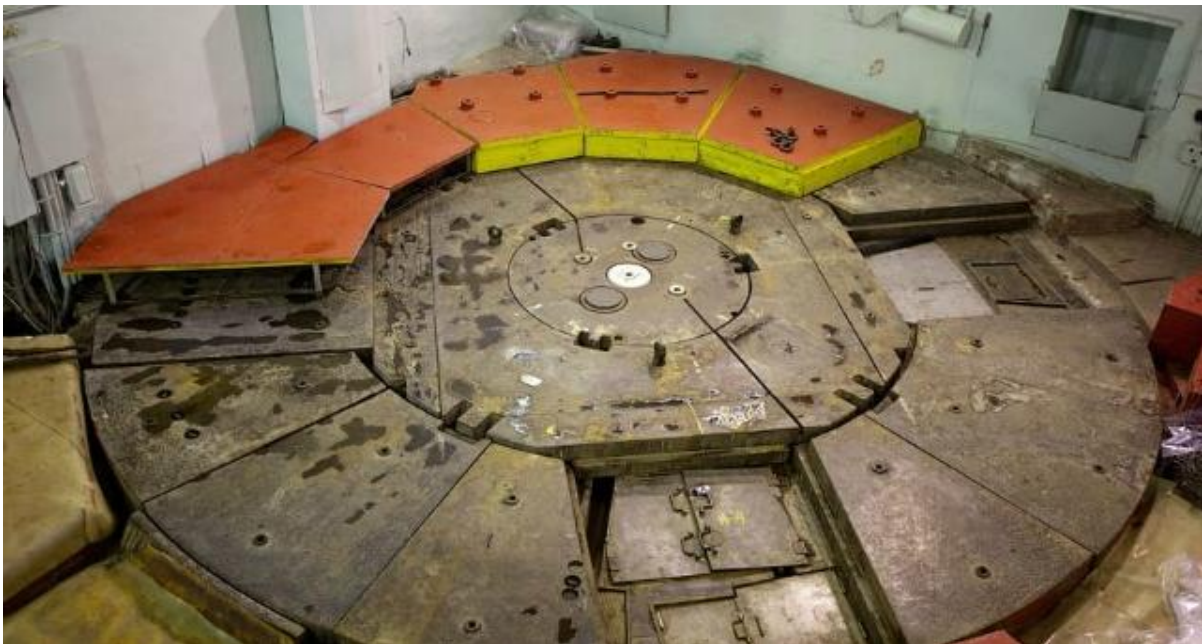
Obrázek 1 První jaderný reaktor vyrábějící elektrickou energii v Obninsku (typ RBMK)
