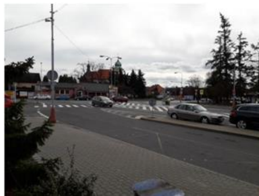
Obrázek 21 Špatný stav VDZ v prostoru zastávky autobusu
