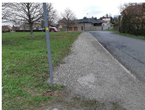
Obrázek 26 Chodník v ulici Pražská
