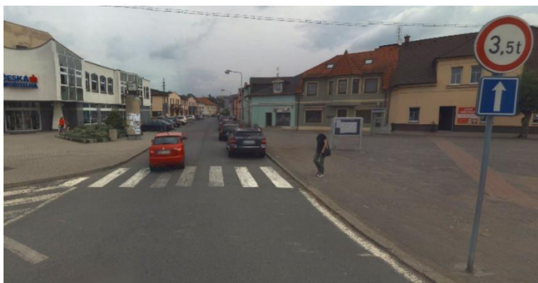
Obrázek 19 Chybějící značka IP 6 a absence prvků OOSPO v místě přechodu pro chodce
