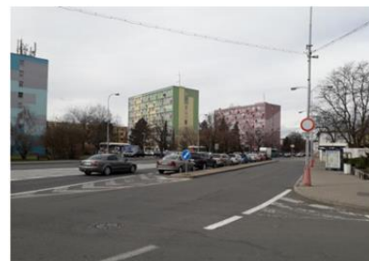
Obrázek 33 Pohled na autobusové zastávky
