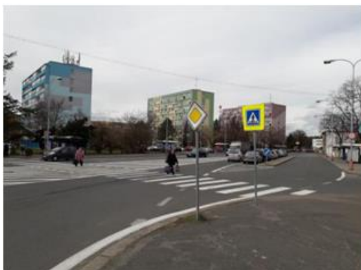
Obrázek 20 Chybějící prvky pro OOSPO a VDZ v prostoru zastávek autobusů
