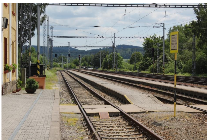
Obrázek 18 - Pohled na 1. a 2. nástupiště
