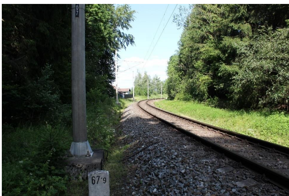
Obrázek 41 - Vedení současné tratě 196 v oblasti pozemku 159/4; km 68,0
