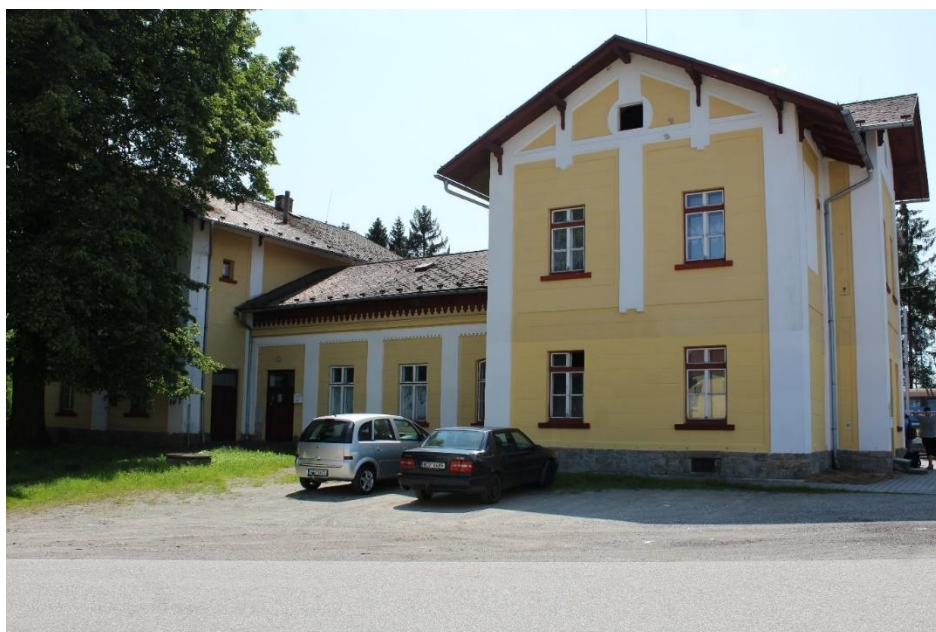
Obrázek 16 - Pohled na výpravní budovu
