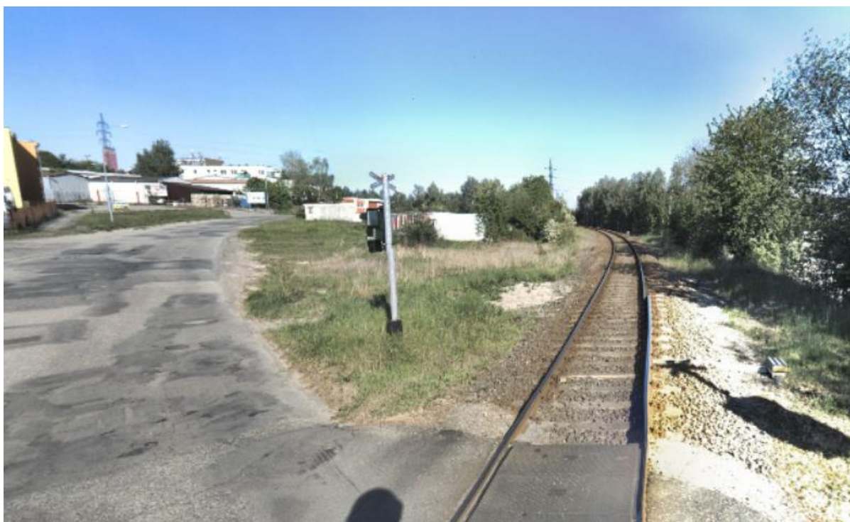
Obr. 24: Prostor, kde by se nacházela nově vytvořená zastávka pohledem ze železničního přejezdu P6405 (zdroj: mapy.cz)
