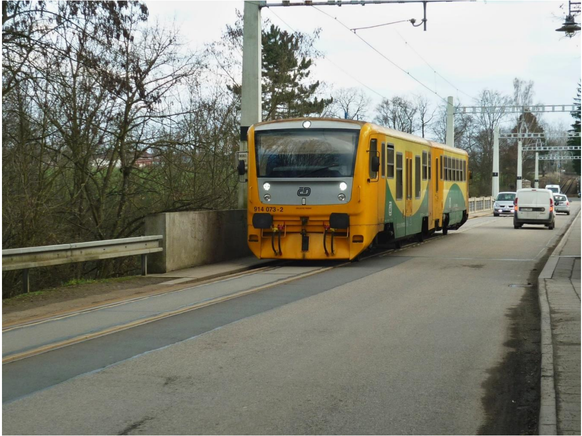
Obr. 7: Společný most pro železniční a silniční dopravu přes řeku Lužnici v Bečnyň (zdroj: https://commons.wikimedia.org/ , autor: Fojsinek)
