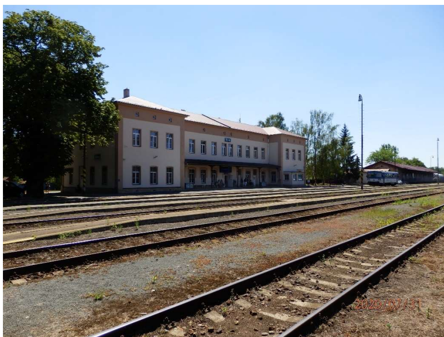
Obrázek 16: Pohled na kolejiště a VB
