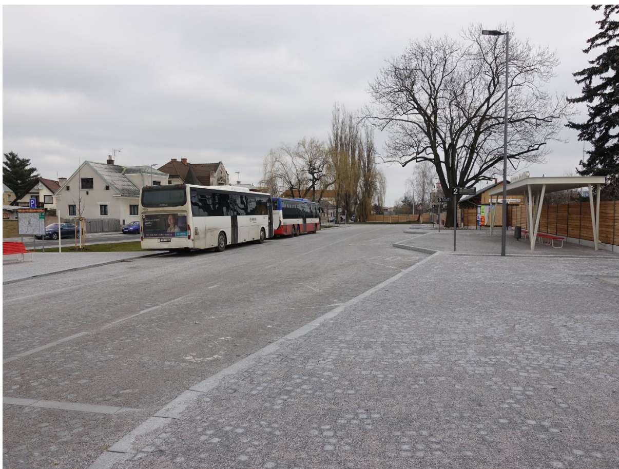
Obrázek 16: Přestupní terminál v přednádražním prostoru žst. Mnichovo Hradiště
