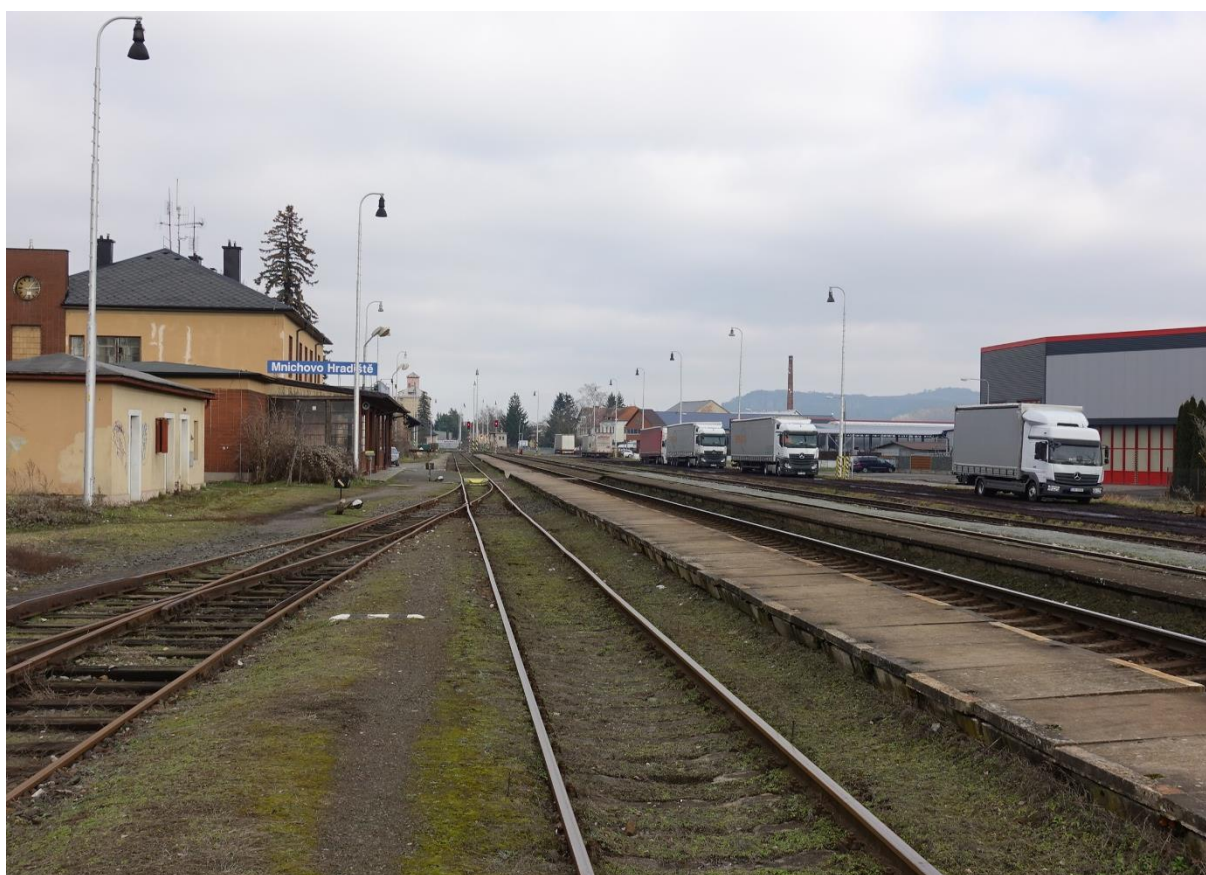
Obrázek 11: Pohled na železniční stanici Mnichovo Hradiště
