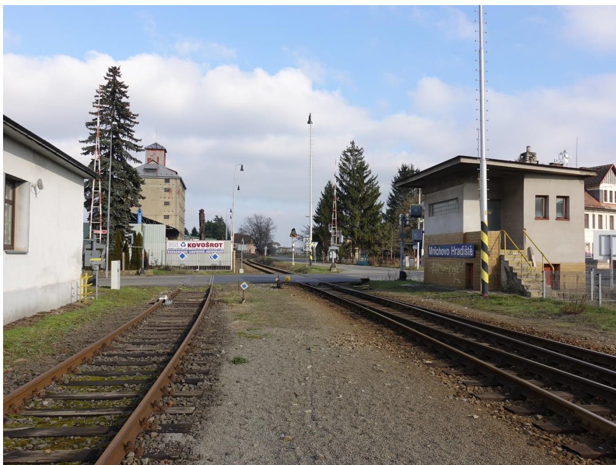
Obrázek 17: Pohled na přejezd 2709 a vjezd na vlečku V1347 na turnovském zhlaví žst. Mnichovo Hradiště
