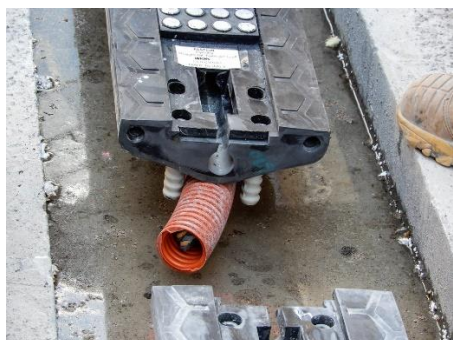
Obrázek 45. Řez napájecím pruhem. [23]
