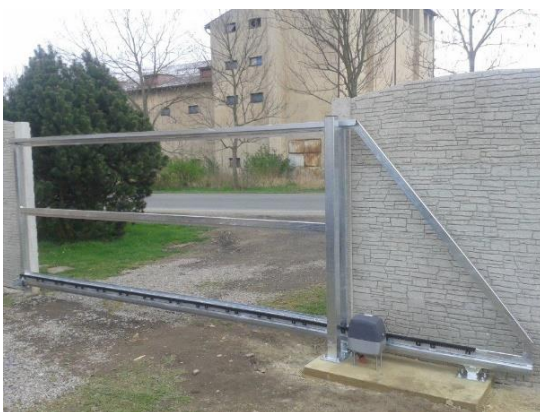
Obr. 2: Rám připravený na výplň [2]
