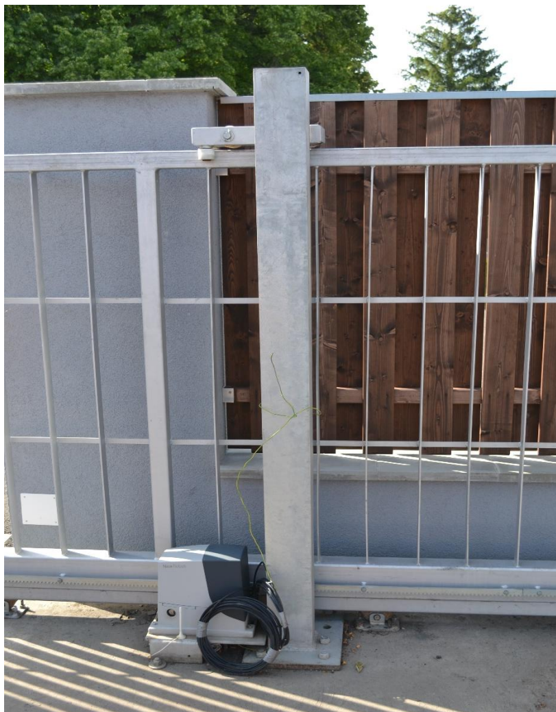
Obr. 42: Detail usazení brány na pastorek a nosné vozíky [autor]
