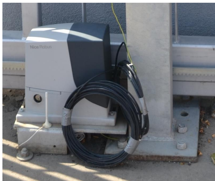
Obr. 69: Detail usazení nosného sloupu [autor]
