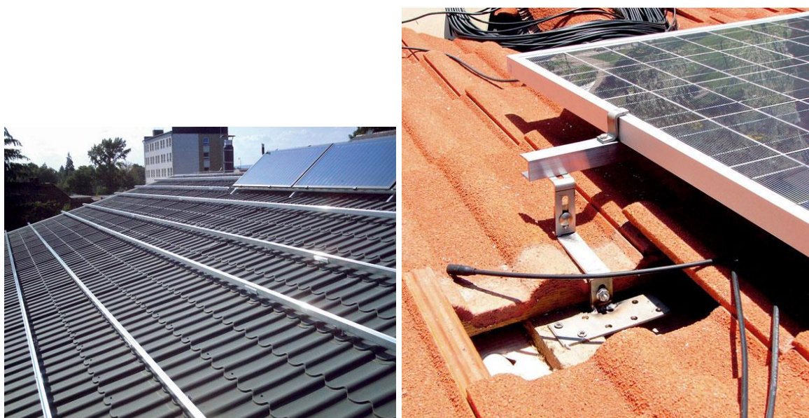
Obrázek 17: Příklad upevnění panelů na šikmou střechu [13]
