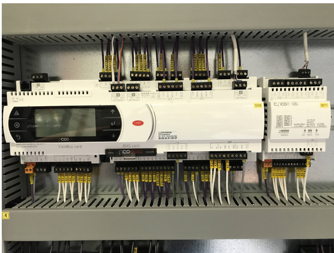
Obr. 3-23 VZT REGENERACE, regulátor CAREL pC05+c.pCOe
