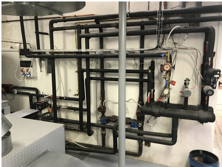
Obr. 3-6 Akumulace a distribuce chladu
