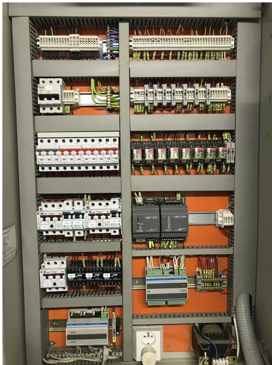
Obr. 5-1 RA-01, umístění nového PLC a modulu DOMAT
