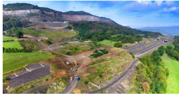
Obrázek 12. Kontrola pozemních prací [5]
