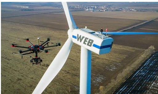
Obrázek 9. Inspekce větrné elektrárny [3]
