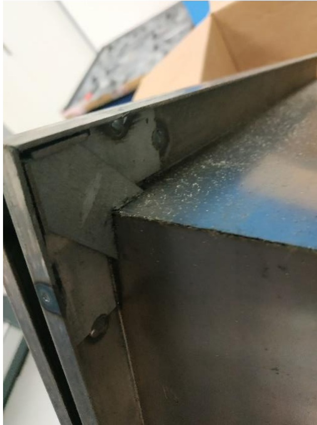
Obrázek 22 Ocelové zárubně osazené přípravkem
