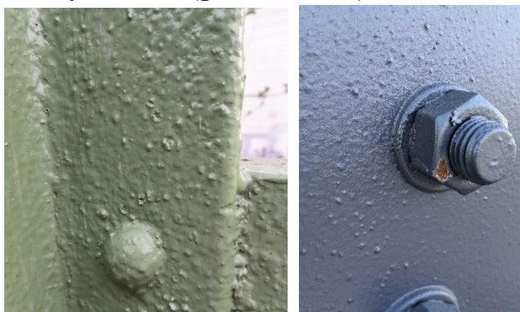
Obrázek 63 - Nečistoty v nátěru
