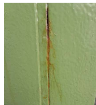
Obrázek 4 - Štěrbínová koroze
