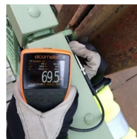
Obrázek 20 - Elektromagnetická zkouška tloušťky nátěru
