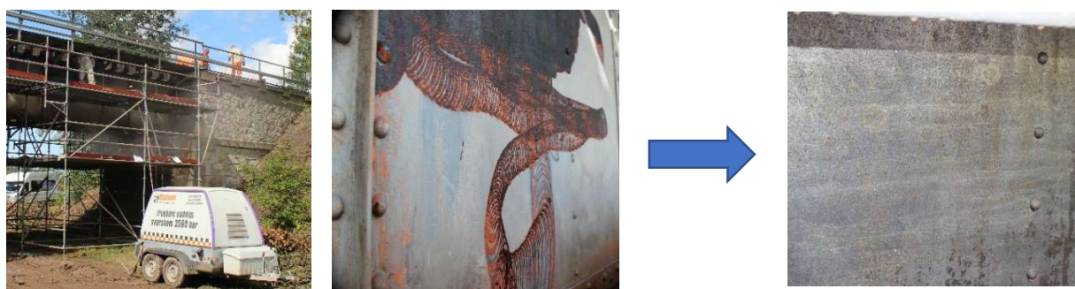
Obrázek 12 - Proces tryskání vodním paprskem
