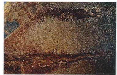
Obrázek 30 - Znečištění olejem [24]
