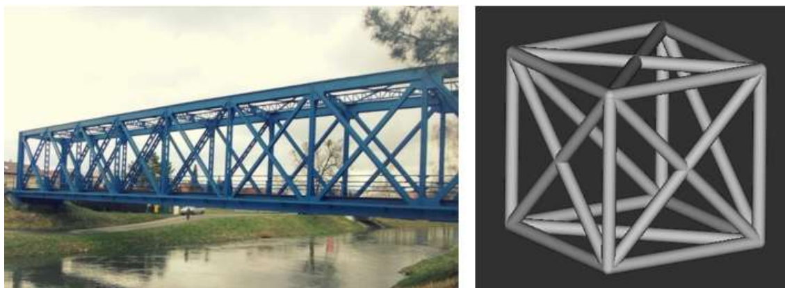
Obr. 2 Nýtovaný ocelový příhradový most přes řeku Moravu [5] a jedna FCC buňka v programu nTopology
