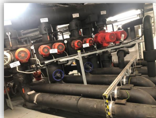
Obr. 18 Oběhová čerpadla
