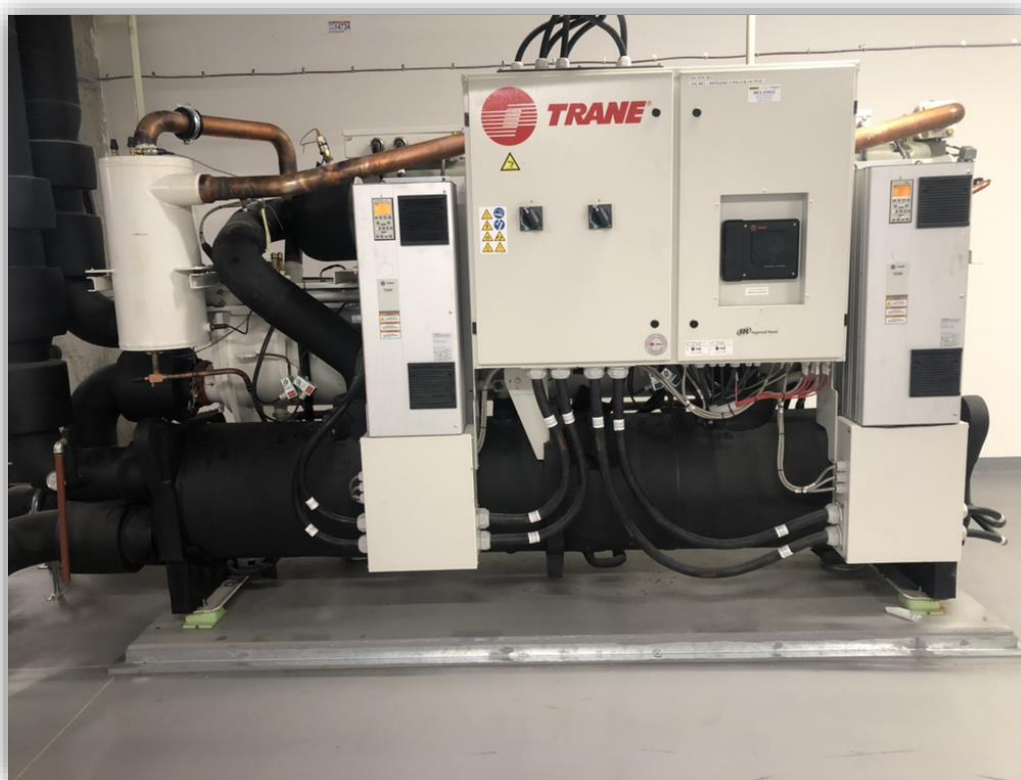
Obr. 23 Chladicí jednotka TRANE RTWD HE
