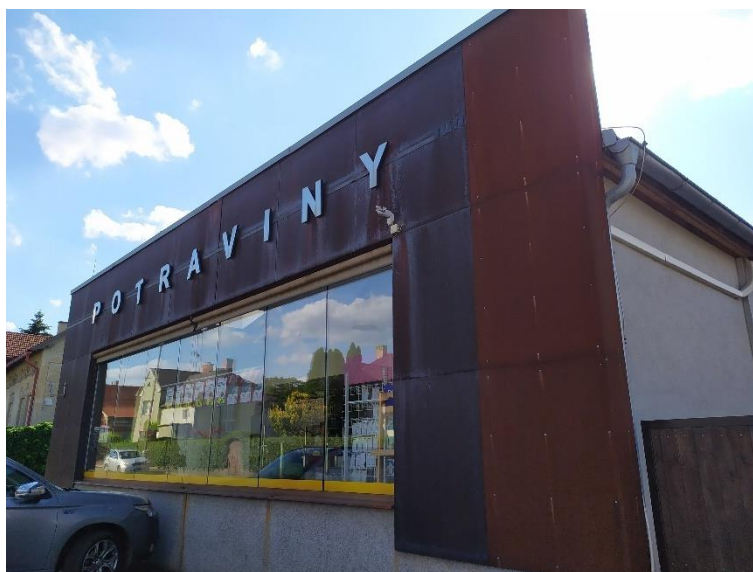
Obr 57 – Opláštění samoobsluhy v Uhlířských Janovicích červenec 2020
