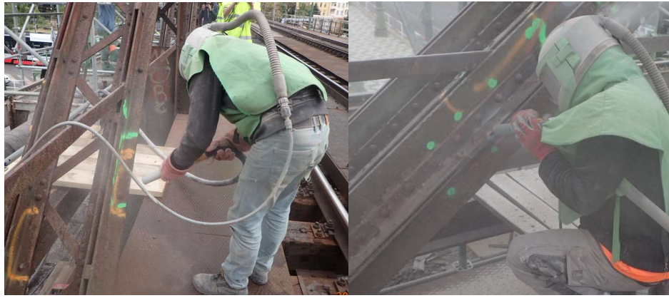
Obrázek 4 - Ukázka tryskání pomocí křemičitého písku (Vyšehradský most) [8]
