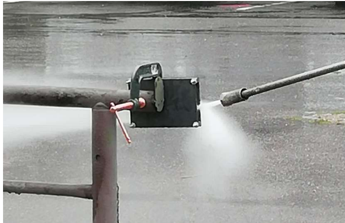
Obrázek 19 - Tryskání tlakovou vodou (2000 bar)
