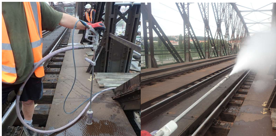
Obrázek 5 - Vlevo: Ukázkou rotační trysky pro tryskání vodním paprskem, vpravo: ukázkou demoliční trysky s vodním paprskem (Vyšehradský most) [8]
