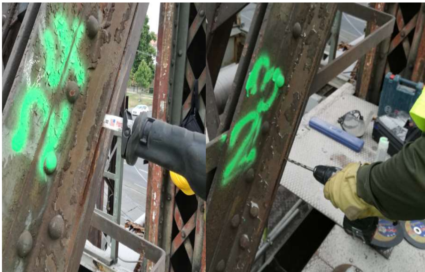
Obrázek 9 - Mechanická předúprava štěrbin pomocí pásové pily (vlevo) a vrtacího kladiva (vpravo) [8]
