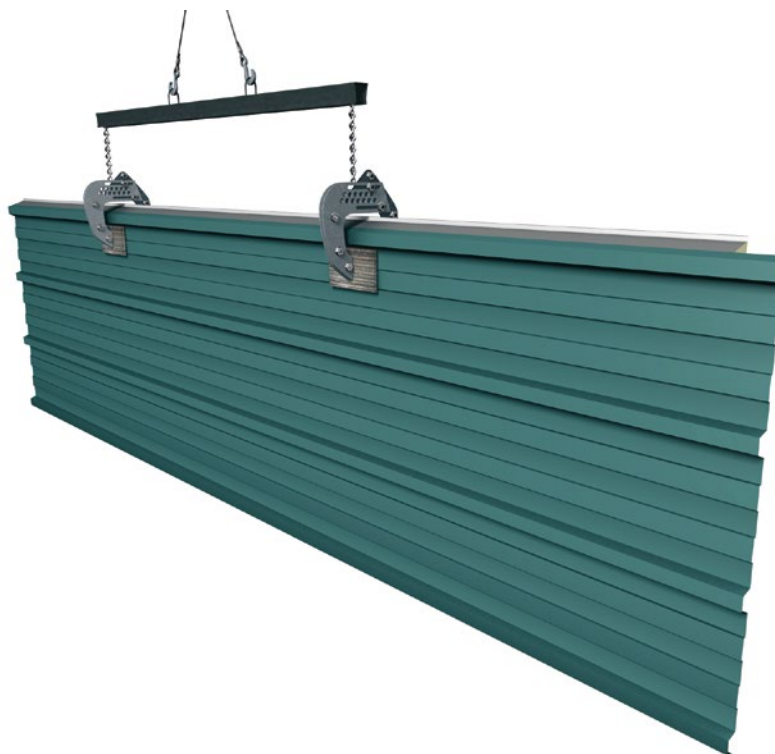
obr. 4.2.4: manipulace se střešním panelem pomocí montážního přípravku („klešтина“ – pro uchycení panelu za pevnou vlnu)
