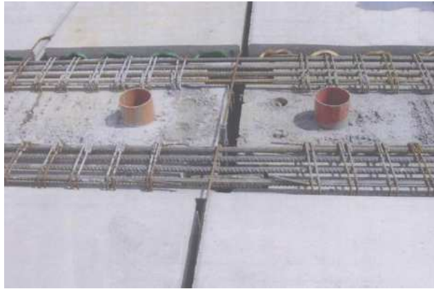
2.22 - prefa-monolitické provedení spoje dílců [21]
