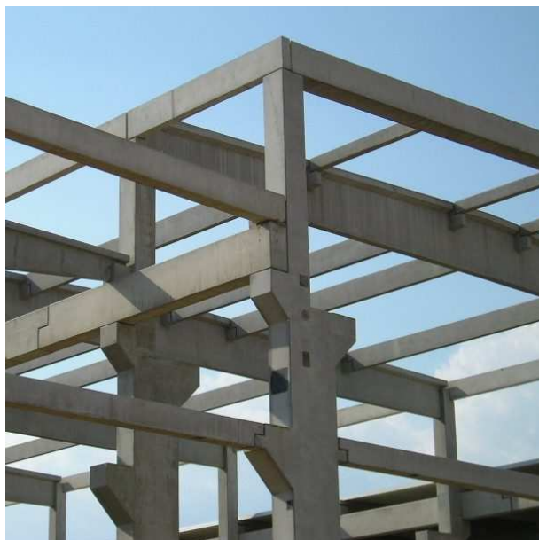
1.4 - spoje prefabrikované sloupové konstrukce, PZ ŠKODA Plzeň [19]
