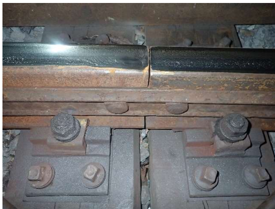
obr. 4 Upevnění K se svěrkou ŽS 3, montovaný spoj
