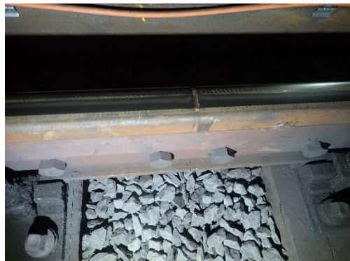
obr. 7 Izolovaný styk
