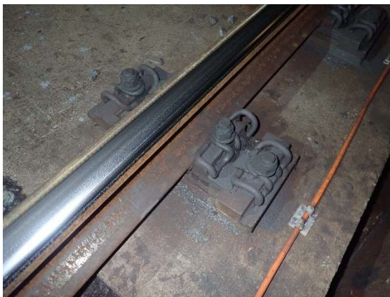
obr. 5 Bezpražcové upevnění
