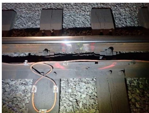
obr. 8 Dilatace pojistných úhelníků
