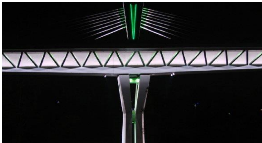
Obrázek 26 Pohled v místě pylonu [9]
