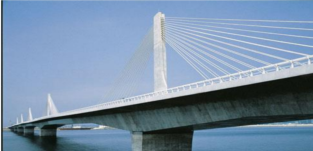
Obrázek 27 Ibi river bridge [10]
