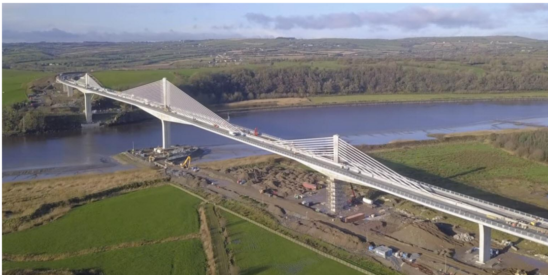
Obrázek 16 Rose Fitzgerald Kennedy bridge [4]
