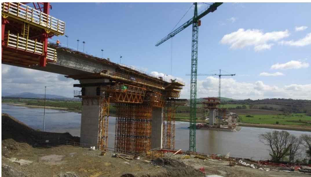
Obrázek 19 Výstavba krajních polí [4]
