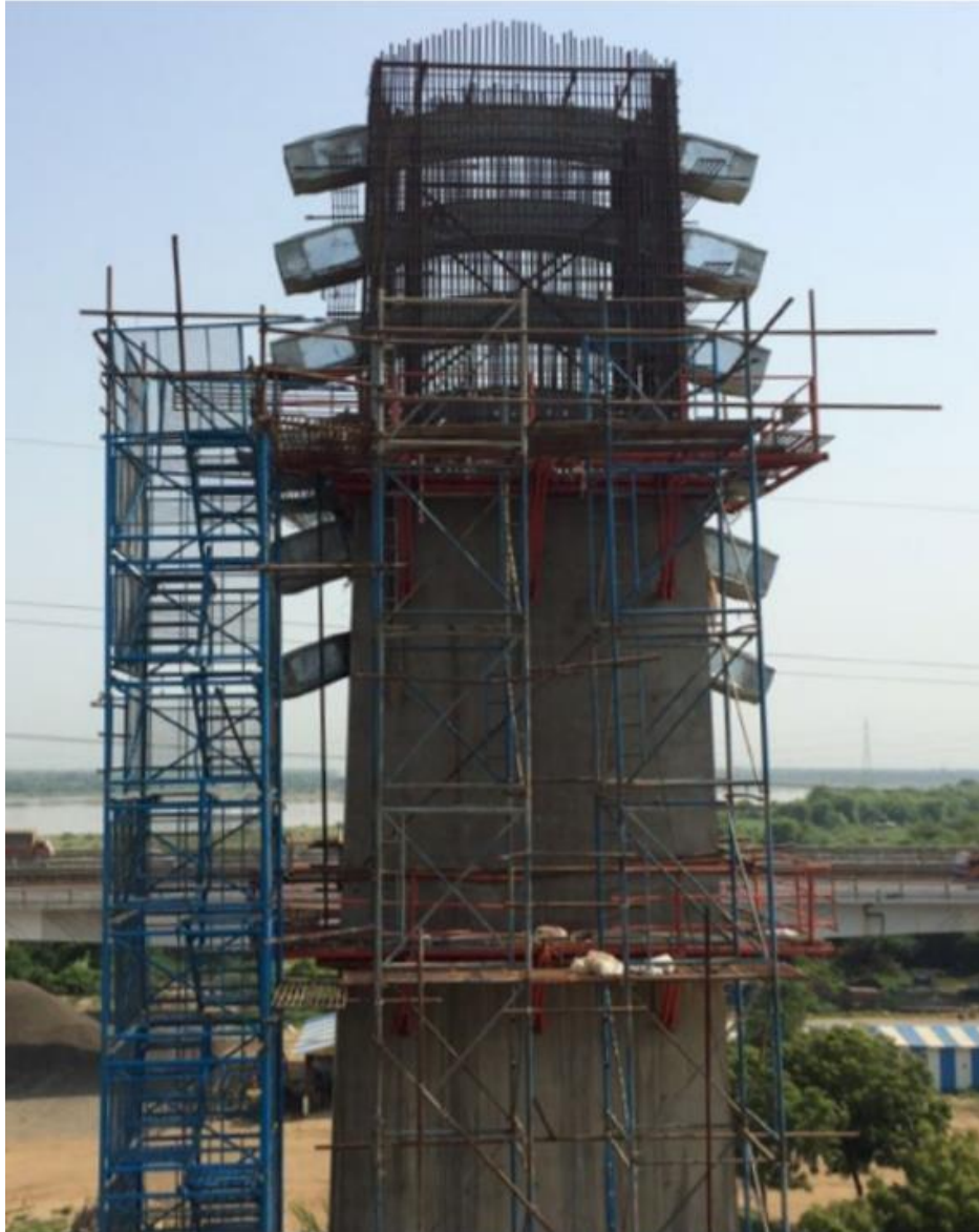
Obrázek 12 - výstavba pylonu se sedly [13]
