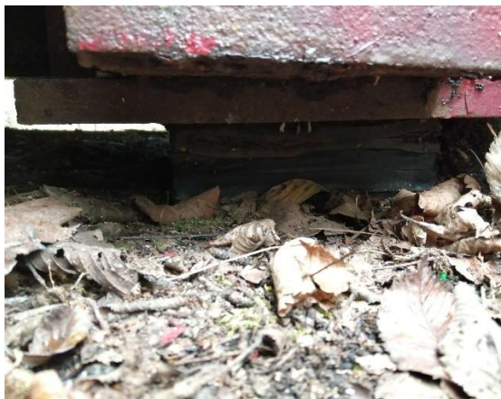
Obr. 10: Elastomerové ložisko
