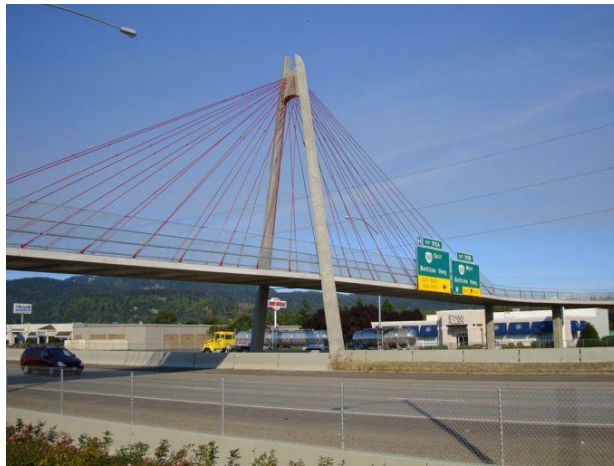
Obr. 65: Lávka před Freeway I-5 Eugene, Oregon, USA [20]
