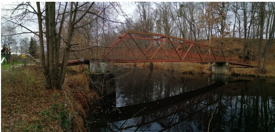
Obr. 6: Lávka 1- spojující levý břeh s Ostrovem
