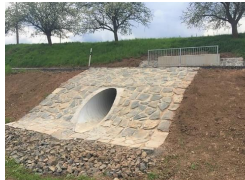
Obr. 32: Názorný příklad propustku [6]
