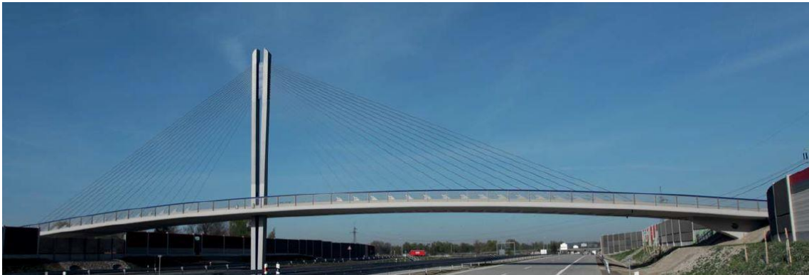
Obr. 63: Lávka přes dálnici D1 v Bohumíně [17]
