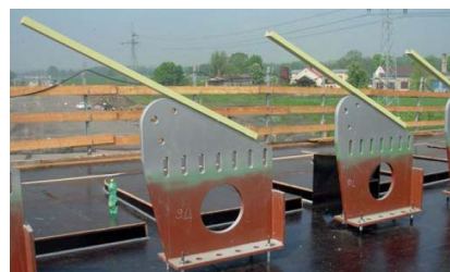
Obr. 62: Ocelové přípravky ke kotvení závěsů [17]
