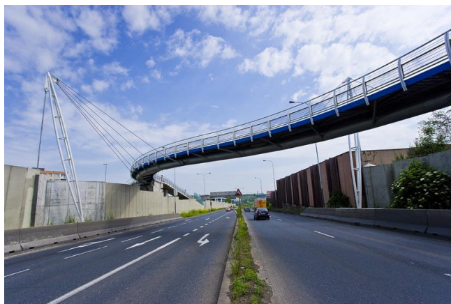
Obr. 60: Pohled na nosnou konstrukci lávky [16]
