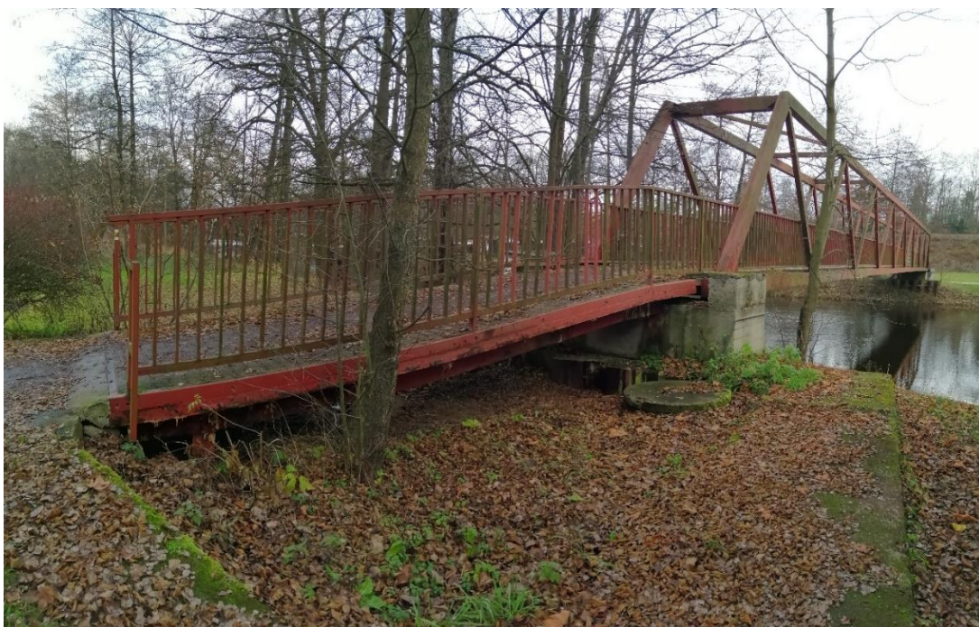
Obr. 7: Lávka 2- spojující Ostrov s pravým břehem
