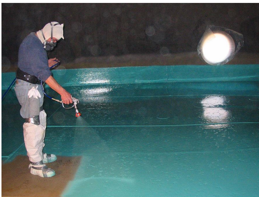
Obrázek č. 21 – Aplikace epoxidové pryskyřice na kov; Foto Waterproof magazine
