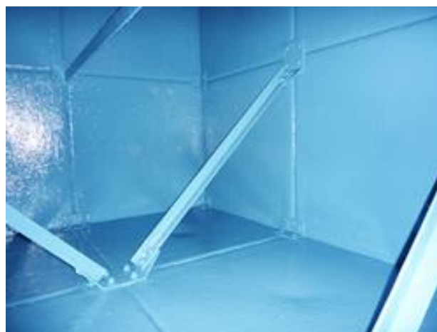
Obrázek č. 48 a 49 – Aplikovaný nový epoxidový povrch na vnitřek kovové nádrže; Foto Specialist-coatings.co.uk
