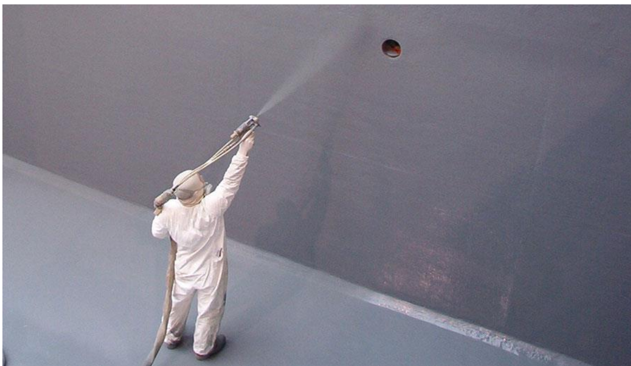
Obrázek č. 20 – Aplikace polyurei stříkáním; Foto Waterproof magazine
