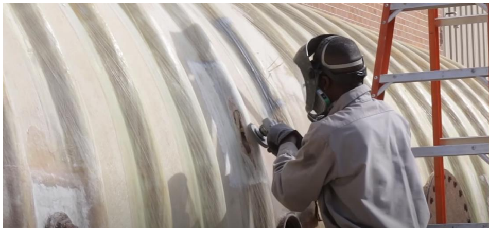
Obrázek č. 57 – Úprava povrchu před zahájením sanace okolo místa poruchy; Foto smooth-on.com
