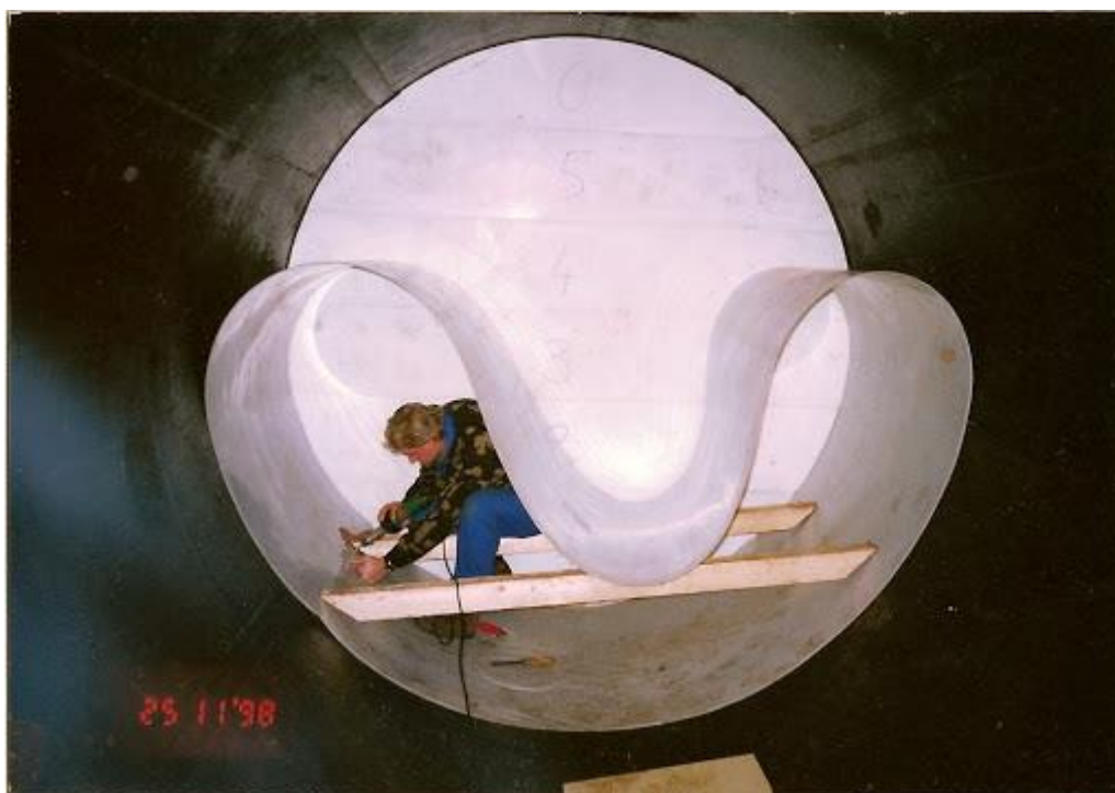
Obrázek č.28 – Fóliová vložka do ocelové nádrže; foto HZPlus.cz
