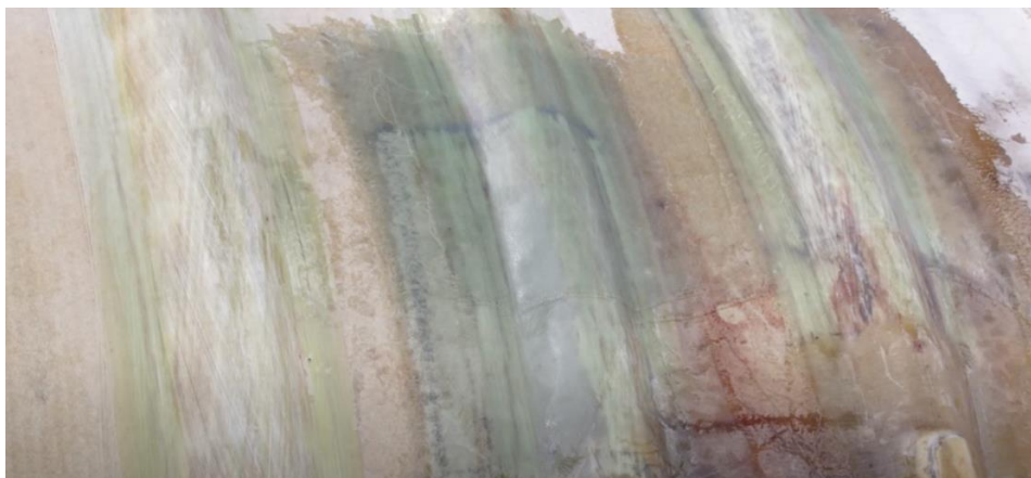
Obrázek č. 58 – Finální stav po opravě porušeného místa; Foto smooth-on.com
