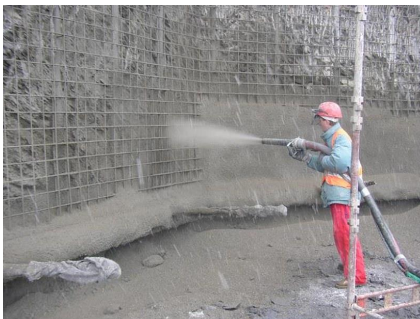
Obrázek č.14 – Sanace betonové konstrukce stříkanou vrstvou; Obrázek BetonServis-VYKO
