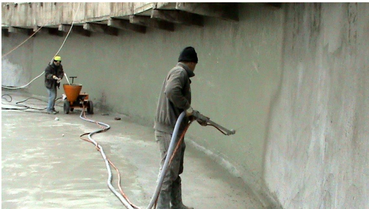
Obrázek č. 19 – Aplikace cementového nátěru na betonový povrch; Foto dreamstime
