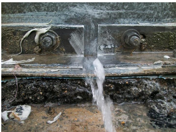
Obrázek č. 54 – Špatně provedená sanace spoje s podkladem; mycoffeepot.org
