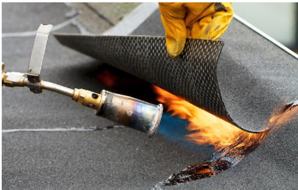
Obrázek č.32 – Aplikace asfaltového pasu; Foto guttashop.cz
