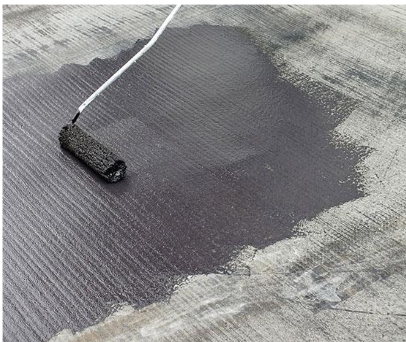
Obrázek č.31 – Asfaltový nátěr aplikován válečkem; Foto chrar-chalupar.cz
