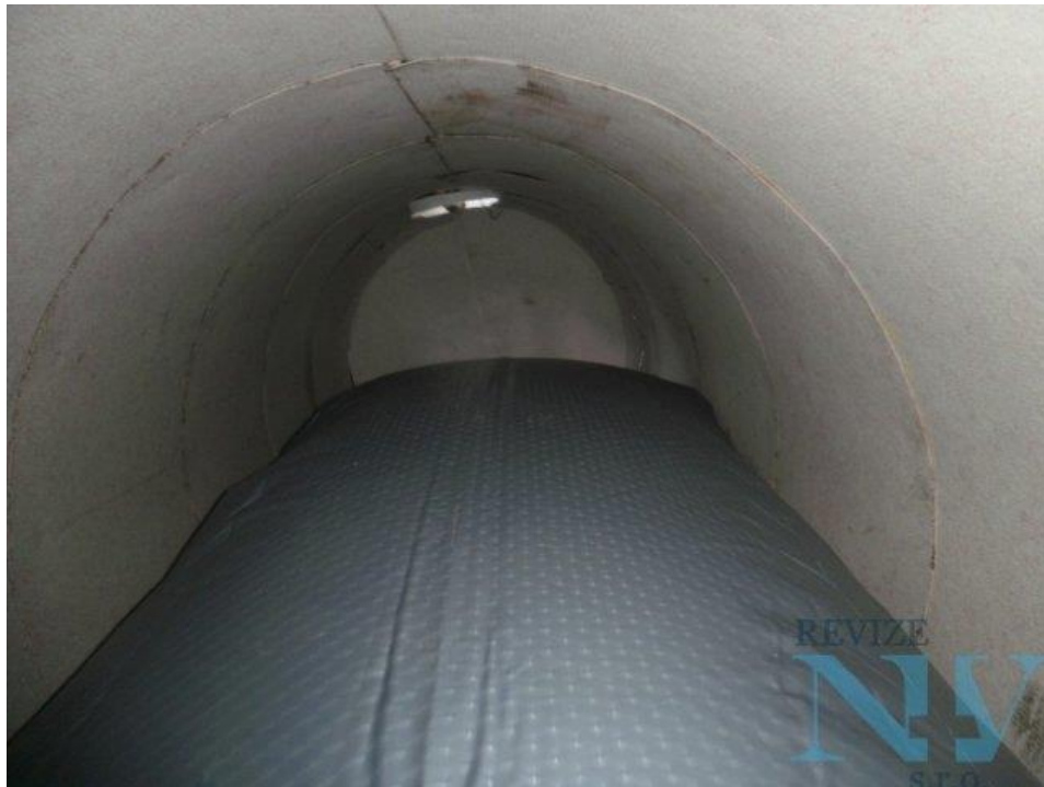
Obrázek č.29 – Nafukovaná vložka v nádrži; Foto cisteni-nadrzi.cz
