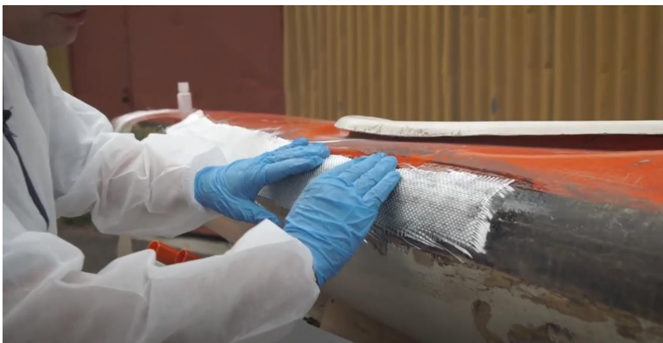
Obrázek č.18 – Aplikace nové vrstvy laminátu za použití tkaniny a pryskyřice
