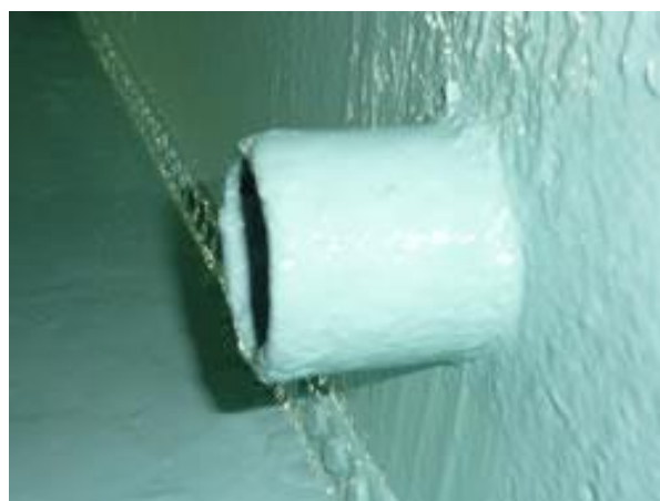
Obrázek č. 50 a 53 – Detail aplikované epoxidové vrstvy na vnitřek kovové nádrže; Foto Specialist-coatings.co.uk
