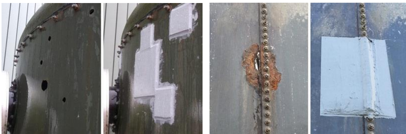
Obrázek č. 46 a 47 – Oprava kovových nádrží záplaty; BankIndustrialGroup.com
