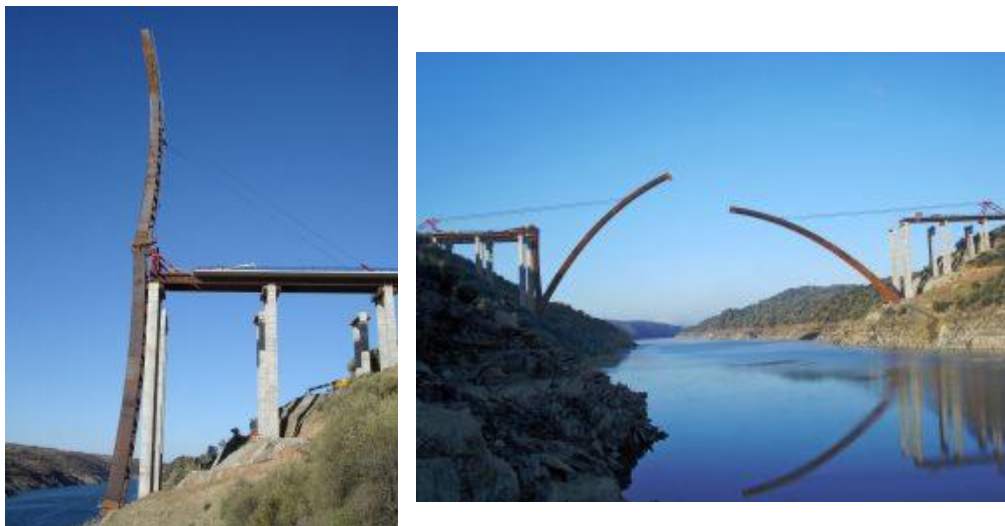
Obr. 2.13 - Sklápění ocelového mostu Alconétar Bridge ve Španělsku [9]
