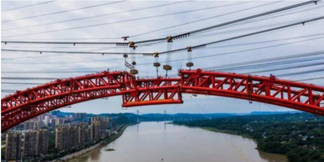
Obr. 2.14 - Realizace příhradového oblouku po segmentech pomocí lan [11]
