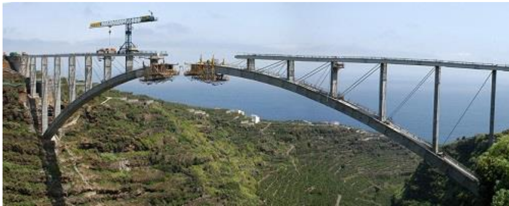
Obr. 2.11 - Letná betonáž mostu Los Tilos na Kanárských ostrovech [8]
