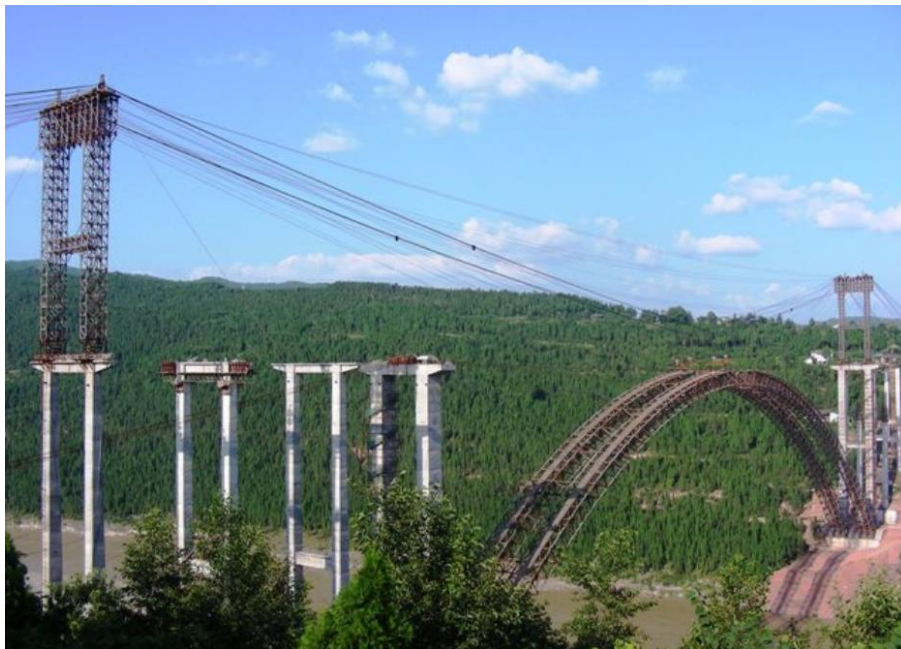
Obr. 2.15 – Realizace příhradového ocelového oblouku [12]
