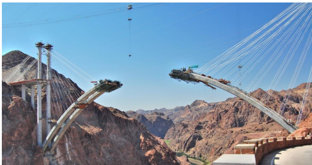
Obr. 2.23 – Výstavba oblouku letmou betonáží s vyvěšováním přes dočasný pylon [17]
