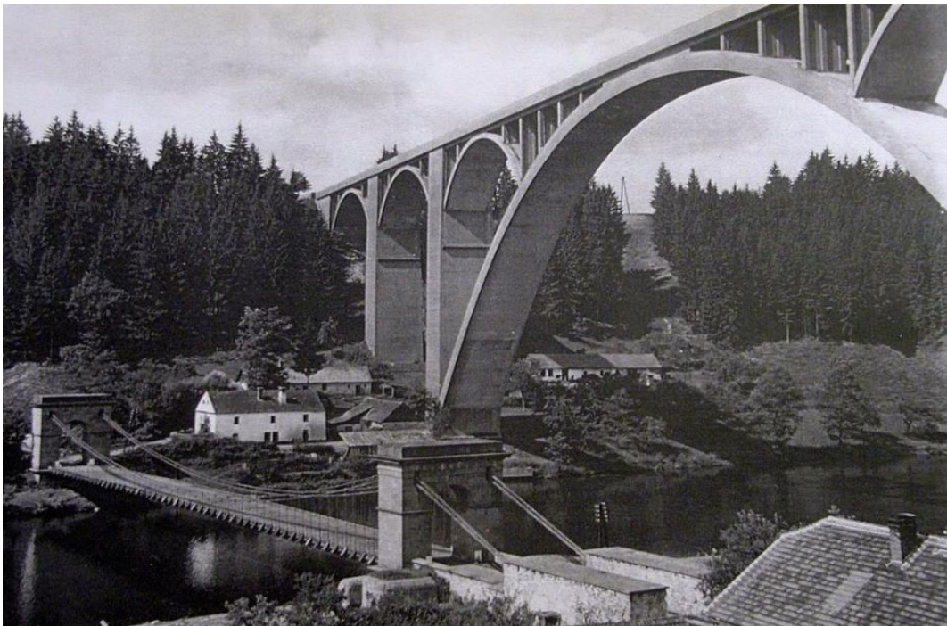
Obr. 2.20 – Podolský most nad starým řetězovým mostem [15]
