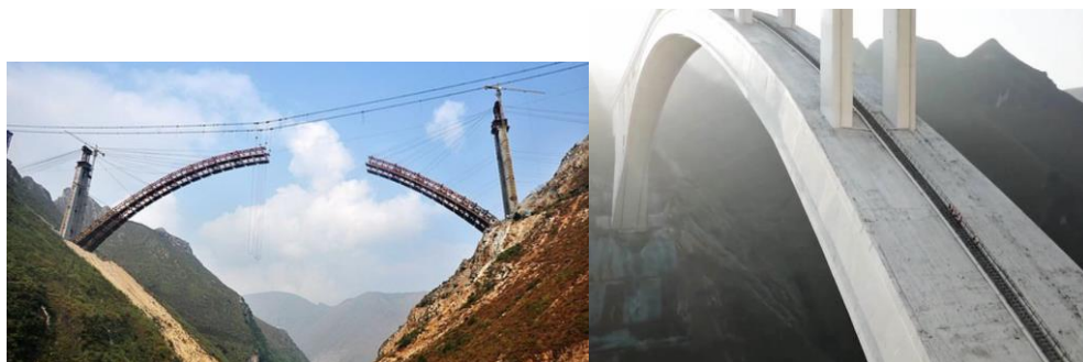
Obr. 2.26 – Výstavba příhradové konstrukce [13] Obr. 2.27 – Pohled na hotový oblouk [13]
