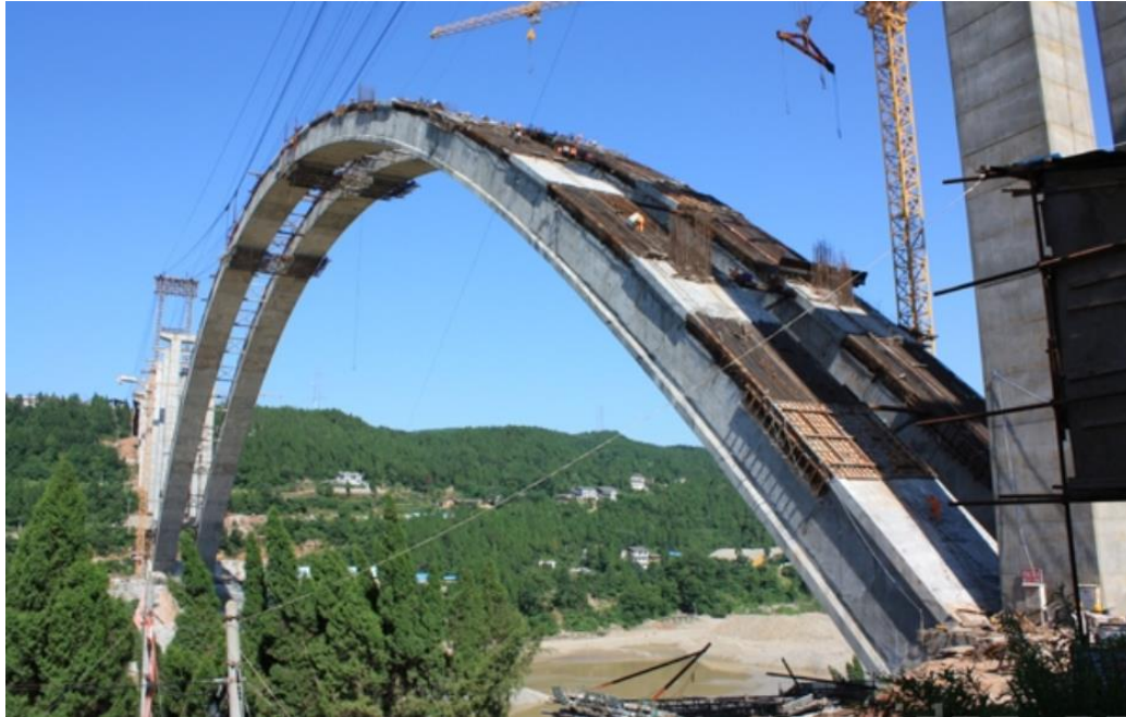
Obr. 2.16 - Odbedňování oblouku mostu Zhaohua Jialing River Bridge v Číně [12]
