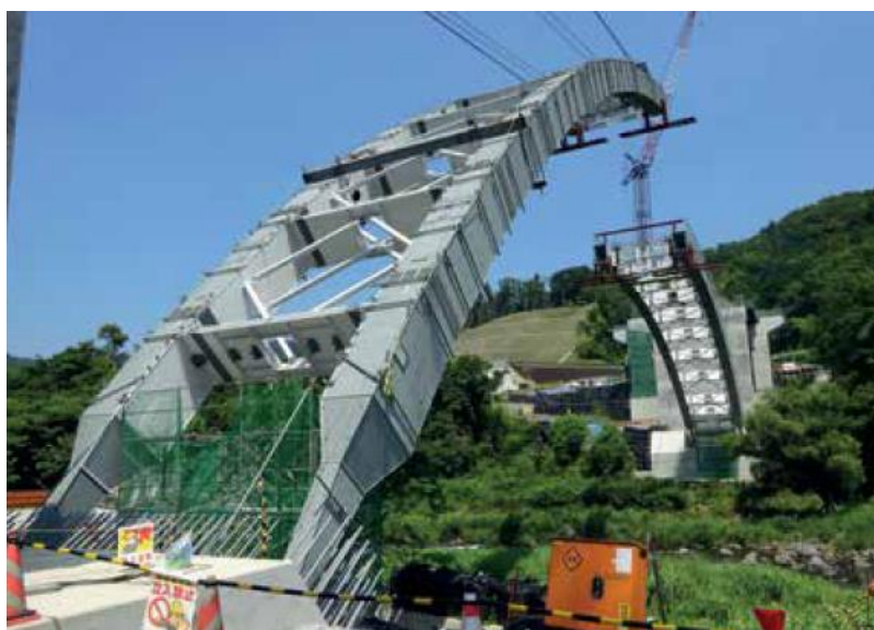
Obr. 2.24 – Sklápění ocelové konstrukce mostu [14]
