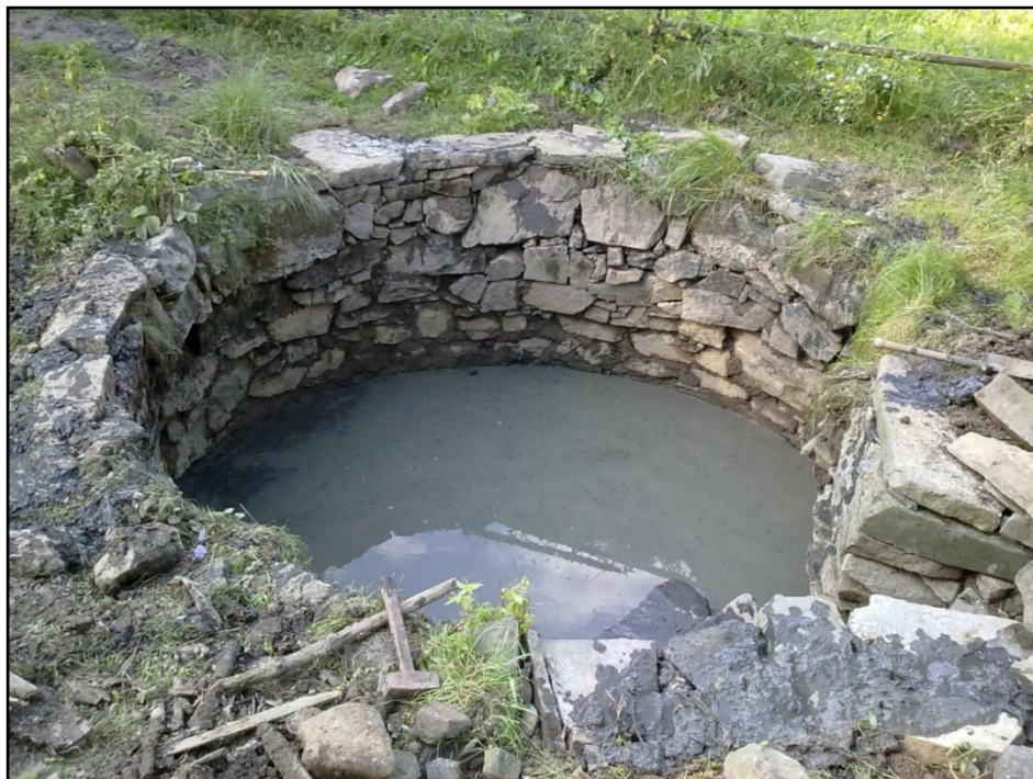
Obrázek 9 Rekonstrukce (odbahnění) rybníčku 2011. Zdroj: vlastní archiv.
