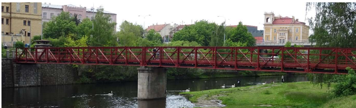
Obr. 3 Pohled na lávku
