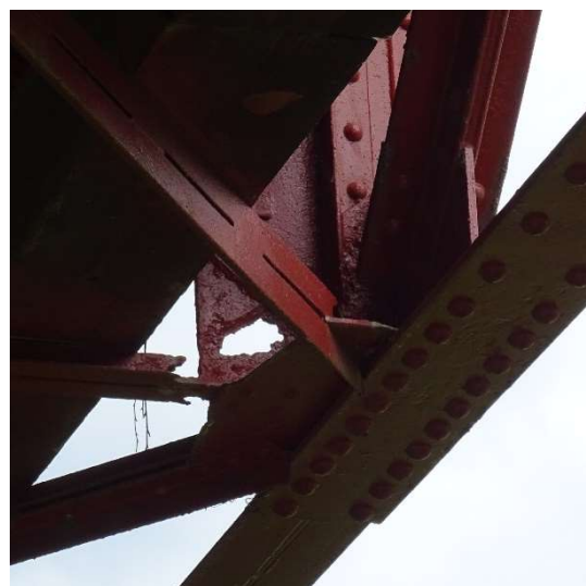
Obr. 15 Detail otvoru ve styčnickovém plechu příčnicku 20
