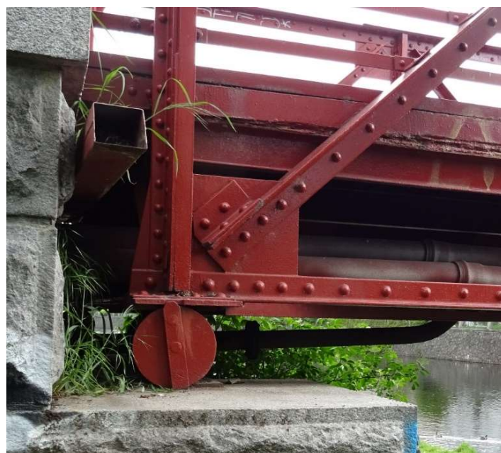
Obr. 5 Detail uložení na krajní opěru
