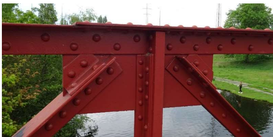
Obr. 4 Detail styčnicku hlavního nosníku
