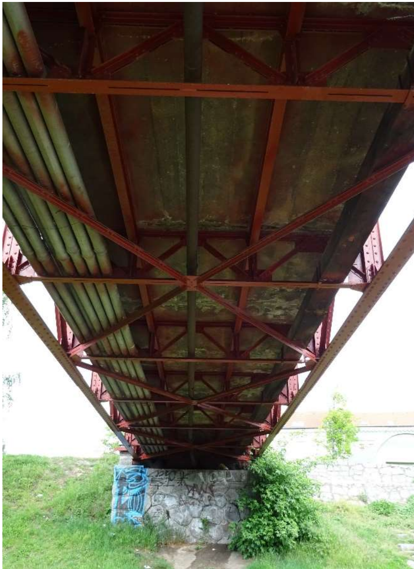
Obr. 12 Pohled na prvky mostovky
