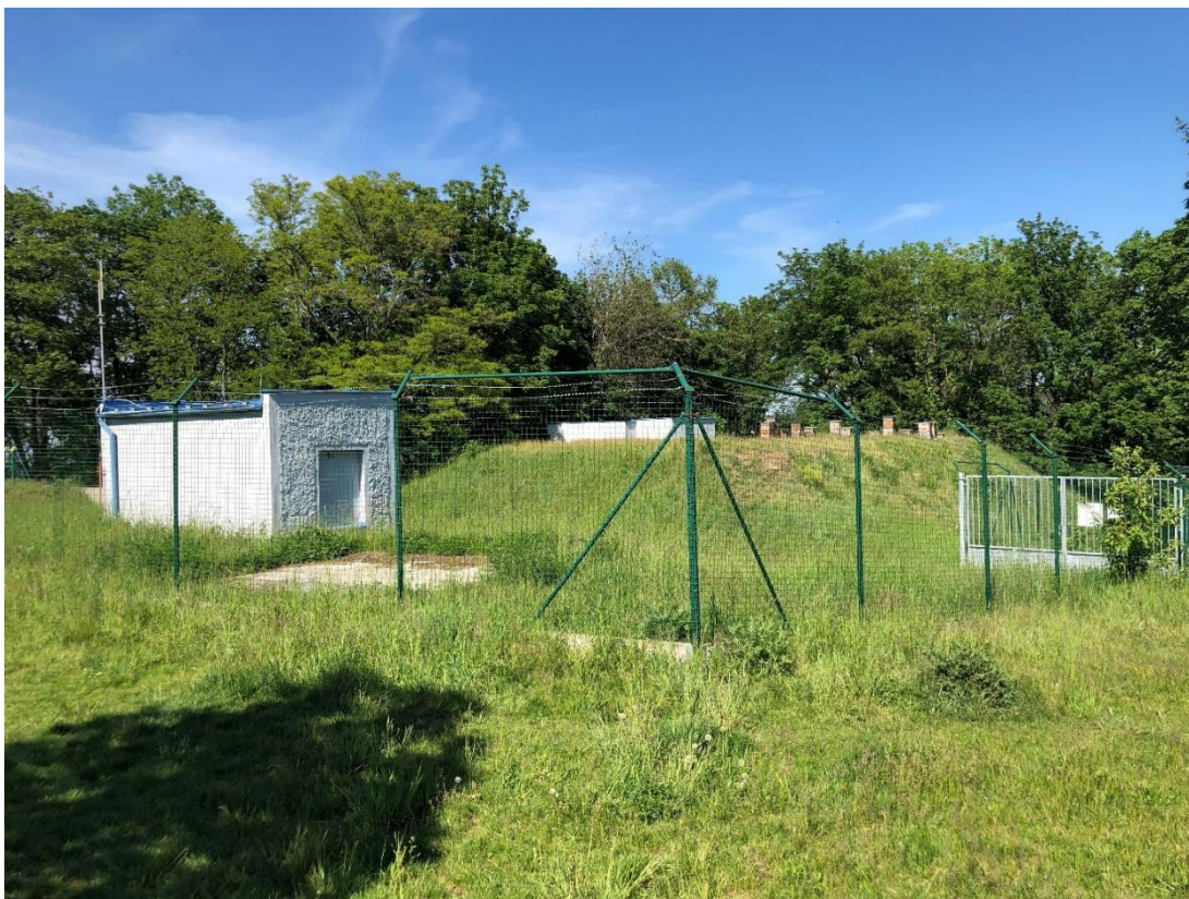
Obr. 22 – Zemní vodojem Havlín
