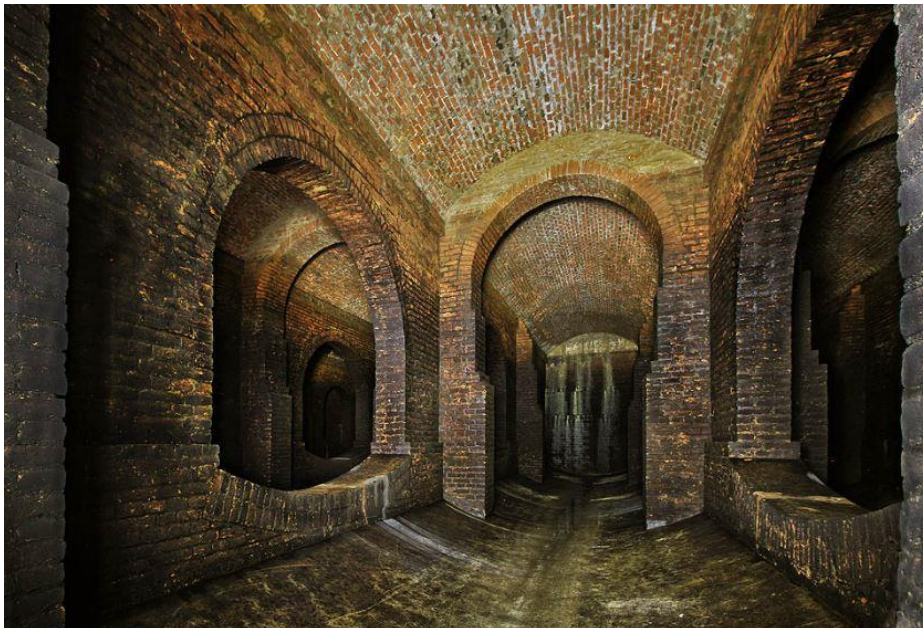
Obr. 10 – Útroby historického zemního vodojemu v Brně
