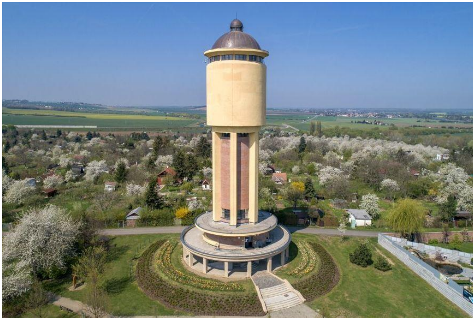
Obr. 11 – Nefunkční věžový vodojem na Kolínsku, který po rekonstrukci slouží jako rozhledna
