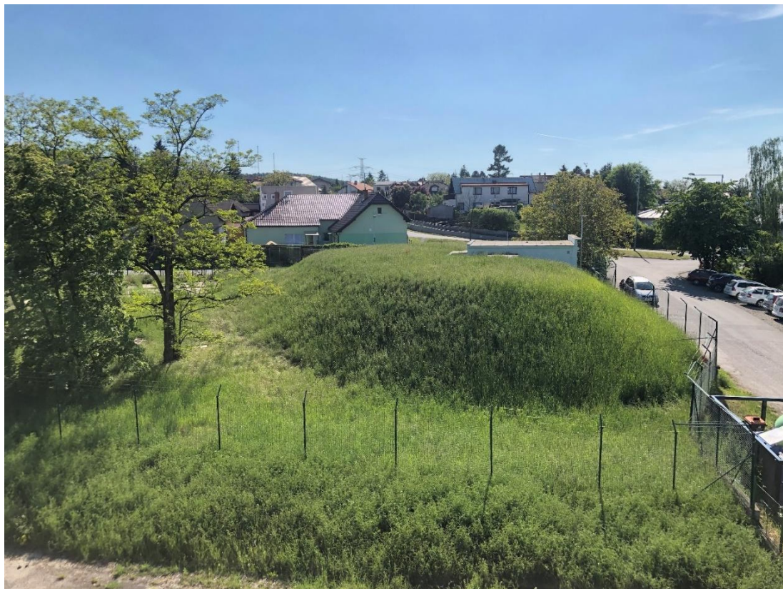
Obr. 23 – Zemní vodojem Baně
