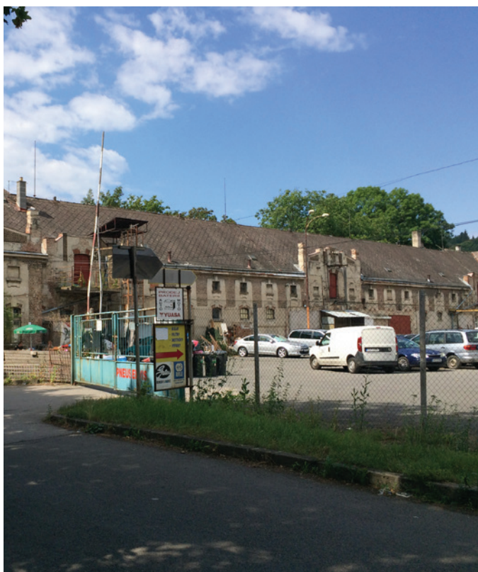
Objekt B - pohled z ulice Ledařská
