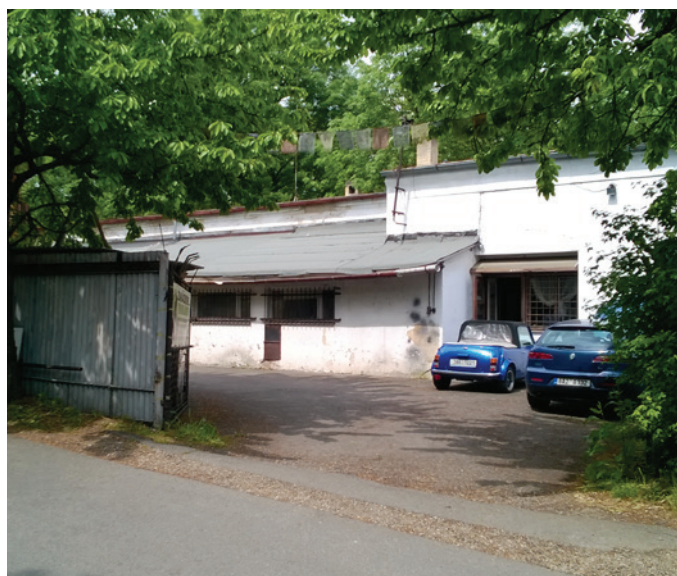
Objekt F - pohled na jižní průčelí objektů
