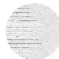
lokálně bílý nátěr zdivo
