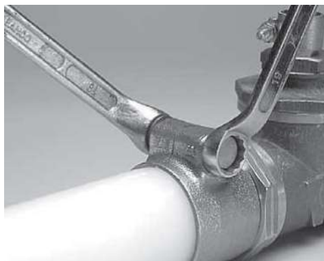
Obr. 10. Zašroubovat šroub tak, aby se obě strany upínací objímce dotkly.
