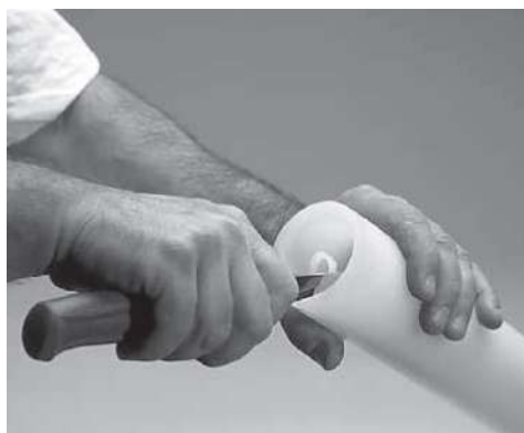
Obr. 2. Po odříznutí odhranit vnitřní hranu trubky.
