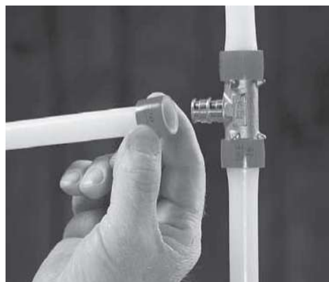
Obr. 2. Nasadit prsteneček na trubku tak, aby více než 1 mm přesahoval konec trubky. Prsteneček musí přiléhat k truce (není-li tomu tak, je třeba prsteneček posunout do hloubky trubky, pomocí expandéru roztáhnout koncovku trubky a znovu umístit prsteneček do správné polohy).
