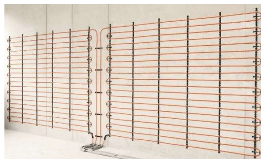
OBRÁZEK 23 – STĚNOVÉ TEPELOVODNÍ VYTÁPĚNÍ [39]
