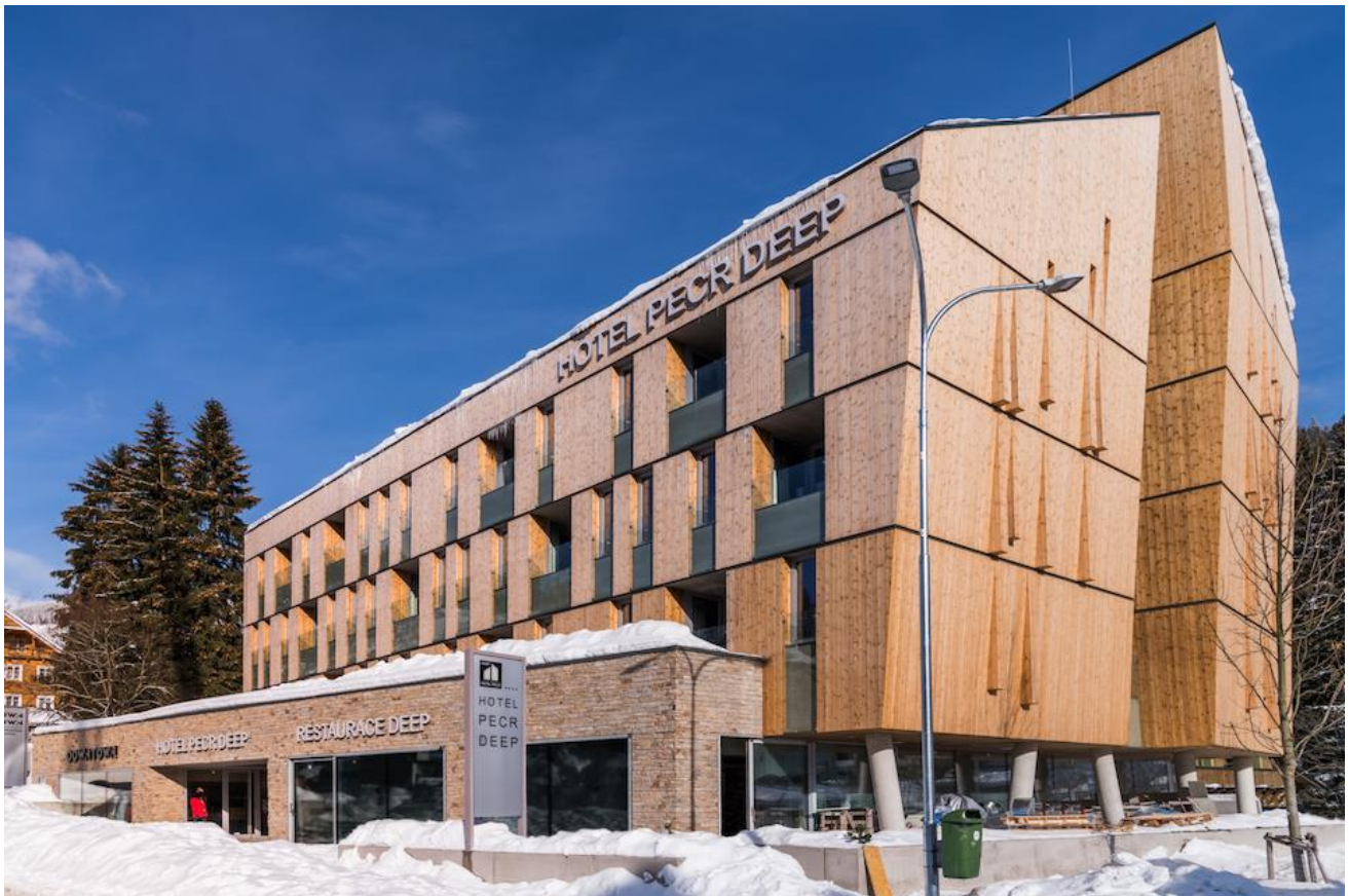
Obrázek 1 Pohled na řešený objekt (zdroj: pecr.cz)
